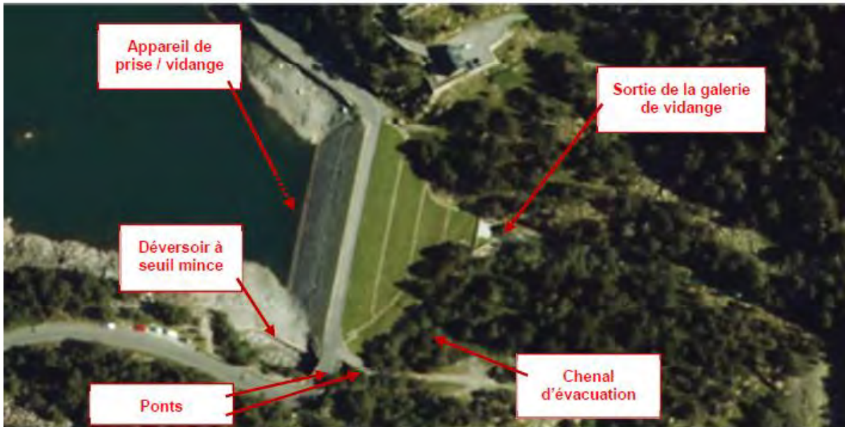
Figure 10 : Détail des organes hydrauliques du barrage d'Orédon (source SHEM)
