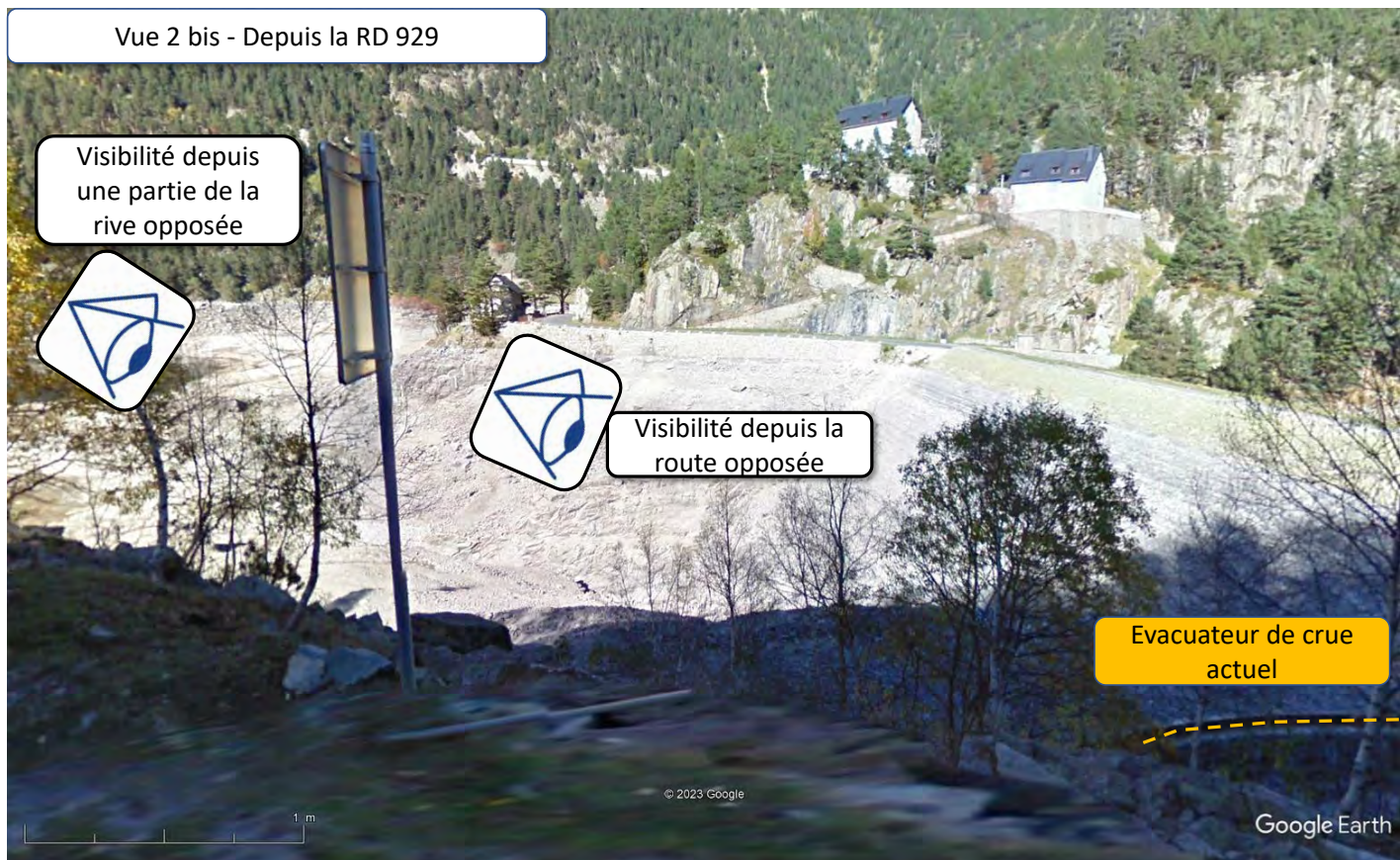
Figure 25 : Vue 2 bis – Depuis la RD 929 (Google street view modifié)
