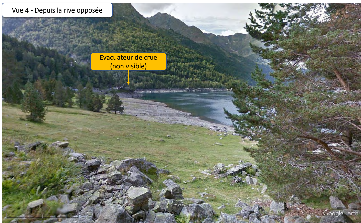
Figure 27 : Vue 4 - Depuis la rive opposée (Google street view modifié)
