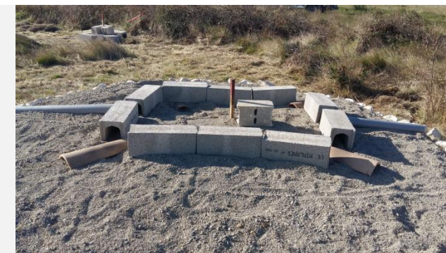
Mise en place du radier en gravas concassés, des éléments constitutifs du gîte
