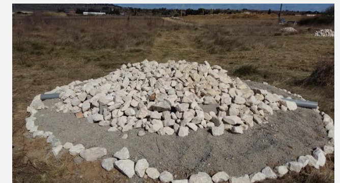
Recouvrement par des blocs de 100-200 Ø mm
