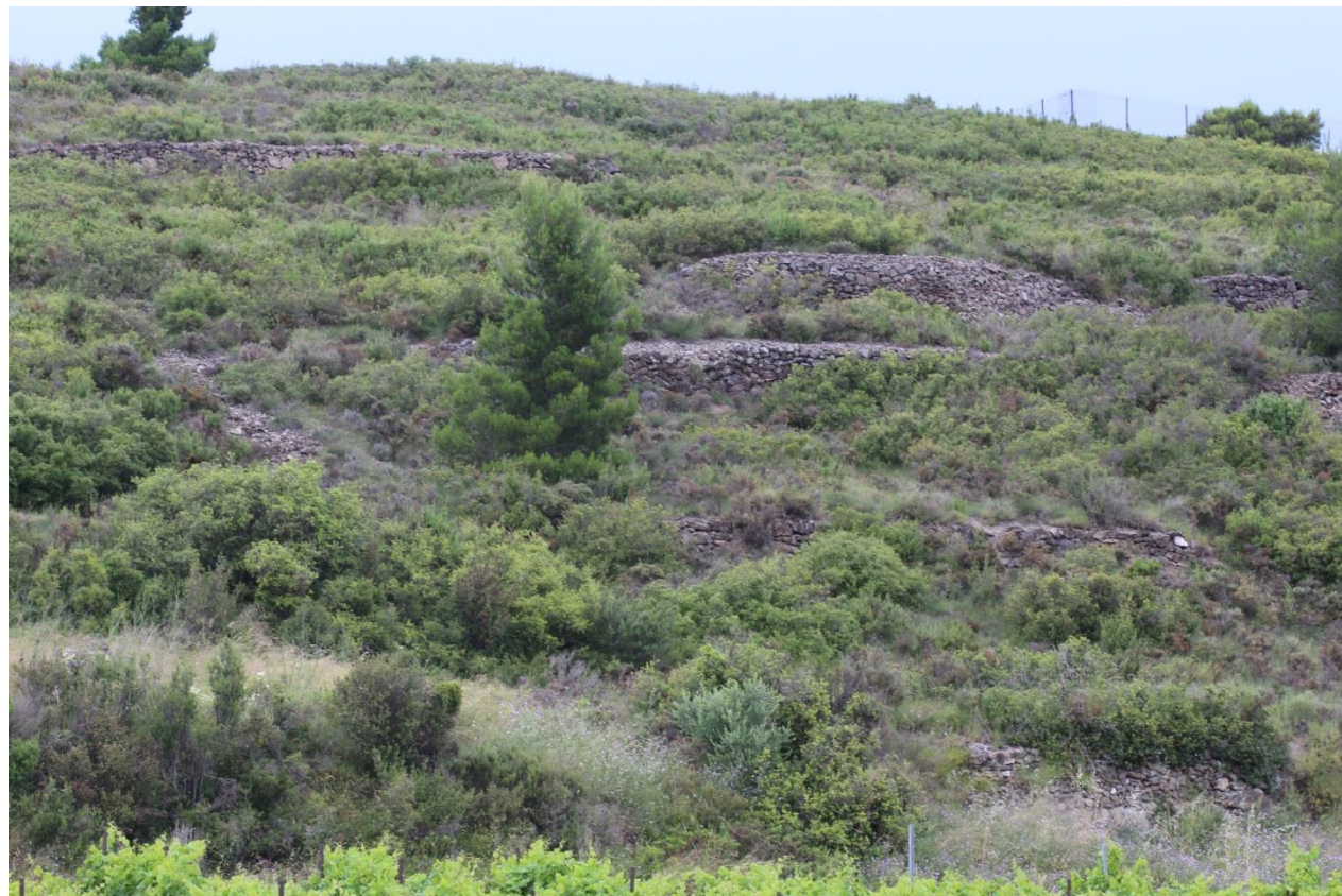
☞ Photographie 69 : Murets de soutènement, ici en bon état (parcelle D2220)
