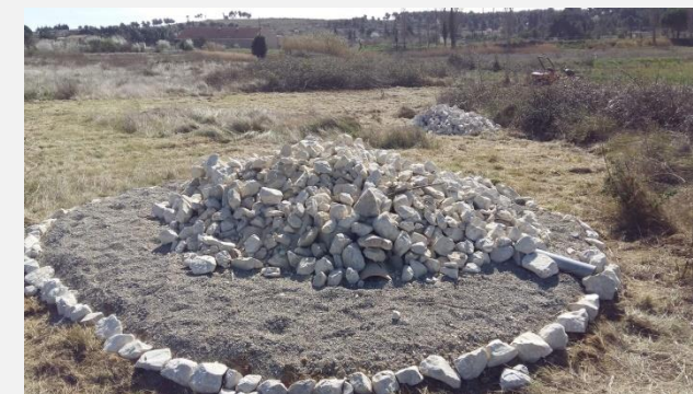
Recouvrement par des blocs de 100-200 Ø mm
