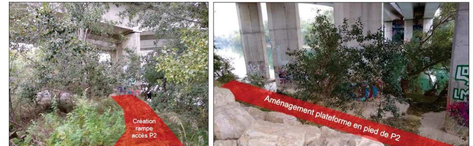
Figure 18 : Localisation schématique et illustration des aménagements pour accès à la pile P2 (Arcadis, 2021)
