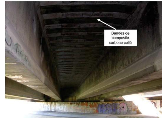
Figure 6: Exemple de hourdis de pont renforcé par tissu en composite carbone collé entre poutres (source : Arcadis MOE PRO)
