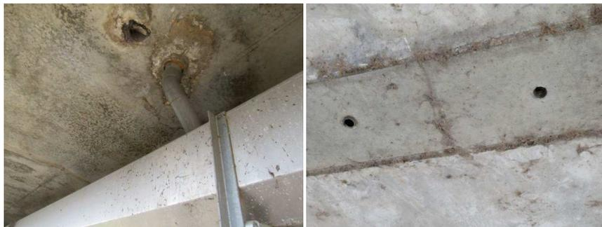
Figure 60 : A gauche présence de guano sur le caisson métallique situé sous le drain ; à droite drain entre les caissons favorable.
