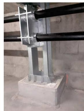
Figure 10 : Illustration d'un déviateur de câbles de précontrainte à mettre en place à l'intérieur des caissons (Photo : Naturalia)
