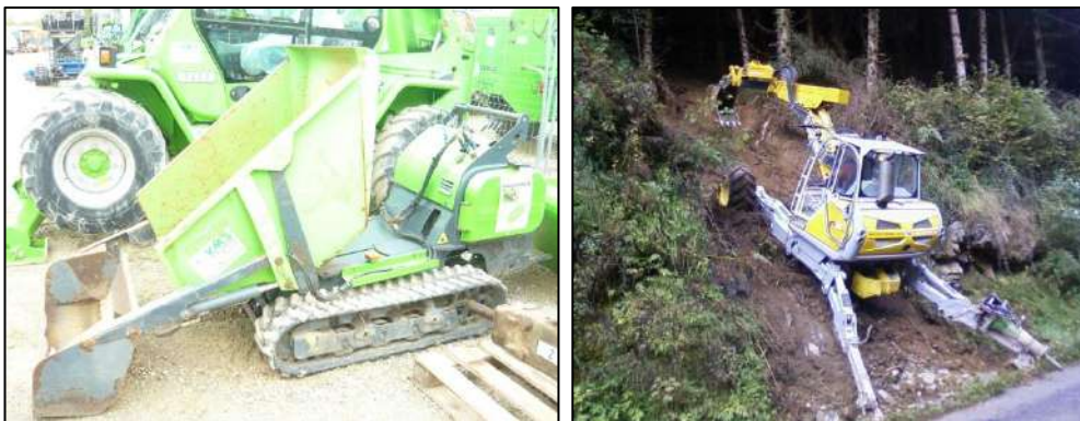
Figure 2 : Engins de chantier utilisés dans le cadre du chantier ©SMDEA
