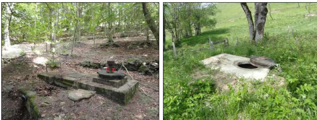
Figure 1 : Exemples d'ouvrages collecteurs AEP ©ETEN Environnement
