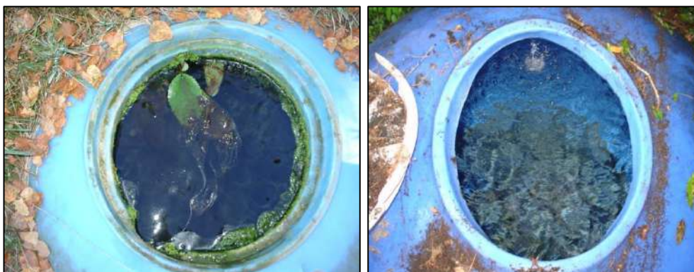
Figure 3 : Photographies de deux cuves de stockage de Boussenac © SATESE09
