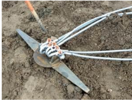
Exemple d'ancrage à vis (Source : CNR)
