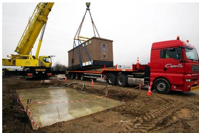
Figure 11 : Installation de postes de livraison et de transformation
