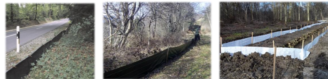
Exemples de barrières : plaques rigides, bache souple et géotextile
