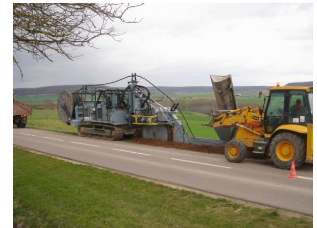
Réalisation de la tranchée
