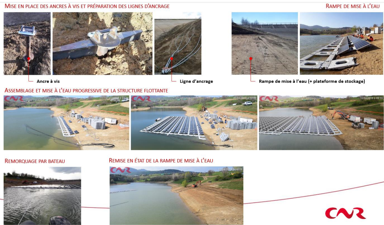
Figure 12 : illustrations d'un chantier de construction d'une centrale photovoltaïque flottante (source : CNR, chantier du parc de la Madone à Mornant)
