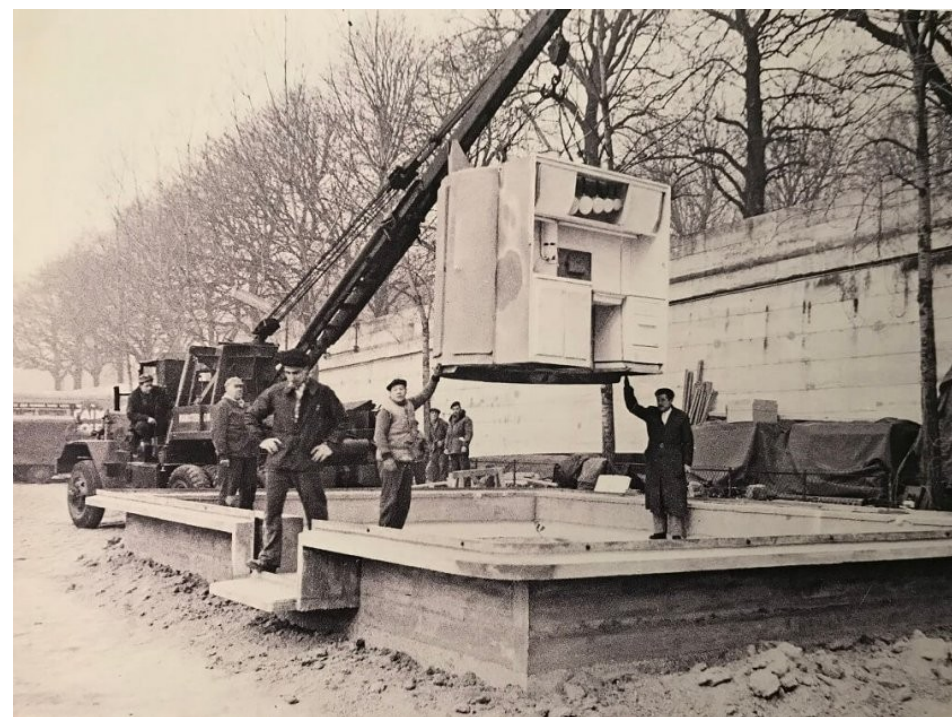
© © Centre Pompidou/MNAM/Bibliothèque Kandinsky/Fonds Jean Prouvé Montage du noyau central sur le socle en béton (1956)
