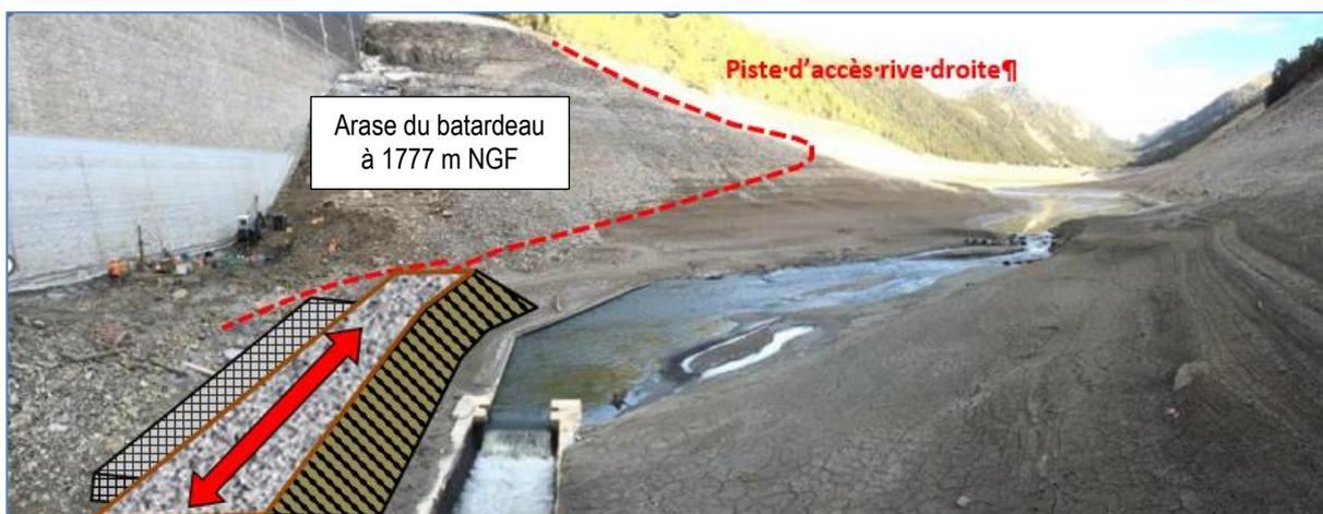
Figure 22 : Représentation schématique du batardeau en pied d'ouvrage ( Vue de la retenue en transparence)
