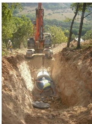
La tranchée et la mise en place de la canalisation à l'extrémité Ouest.
