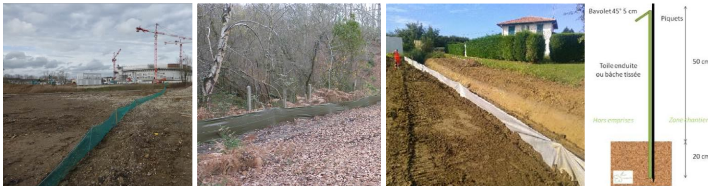
Exemples de barrières anti-batraciens/ systèmes de filtration ceinturant un chantier (Source : Simethis)
