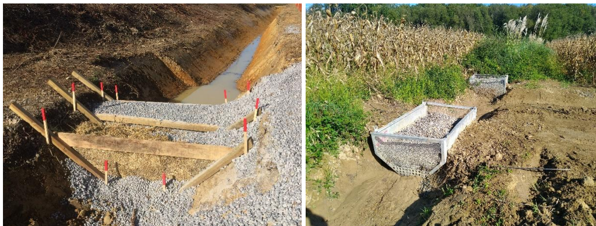
Figure 23 : Exemple de système de filtration (Source : SIMETHIS) Filtre à paille/cailloux, filtre à cailloux
