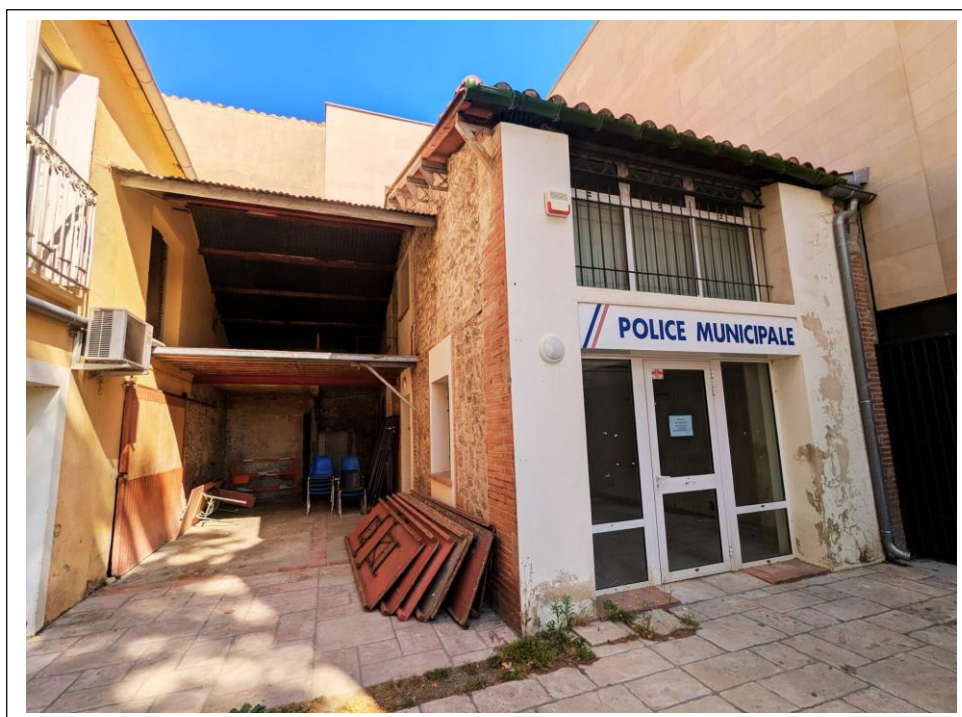
Ancien bâtiment à démolir
