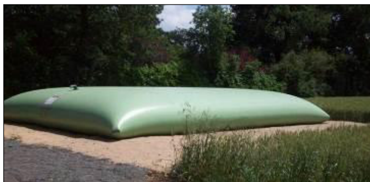
Figure 7 : Exemple de citerne incendie souple (source : Inddigo)
