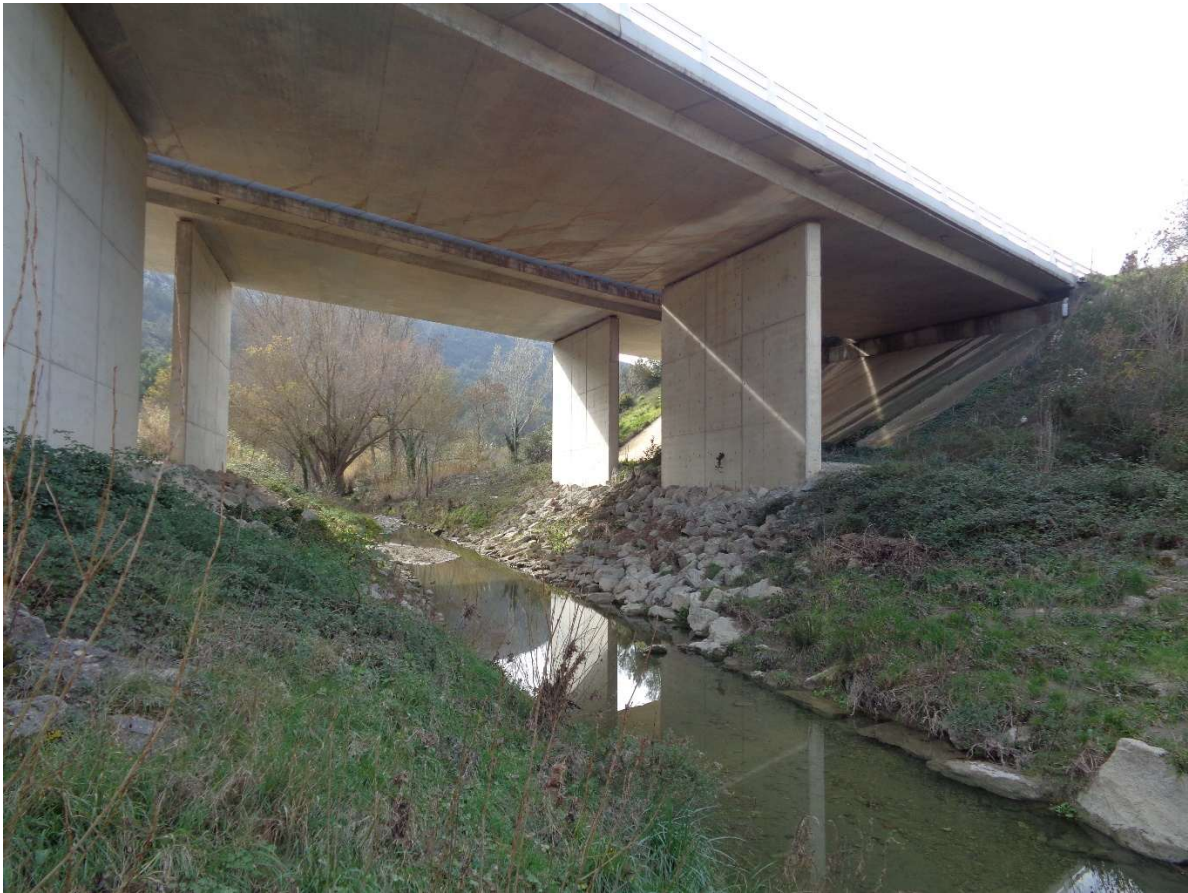
Figure 14 : Ouvrage de franchissement « est » sous l’A61
