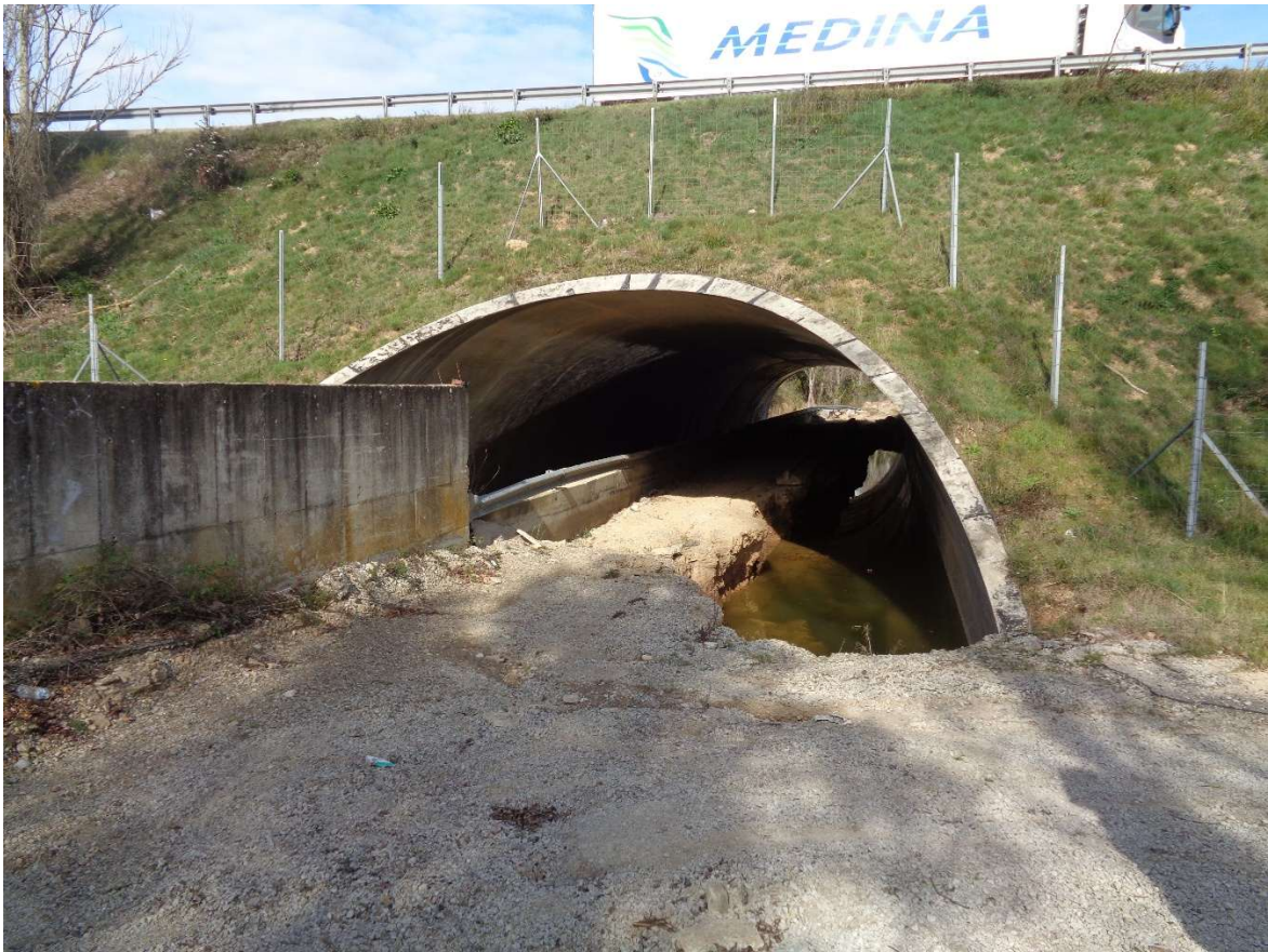
Figure 13 : Ouvrage de franchissement « ouest » sous l’A61
