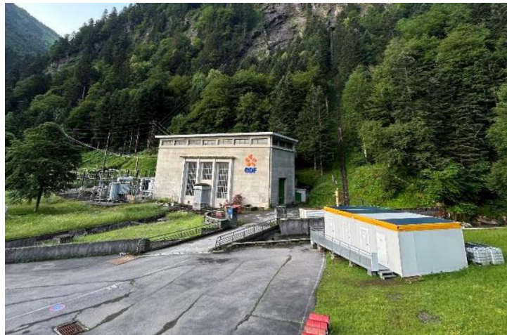
Figure 16 : zone d'installations de chantier à proximité de l'usine
