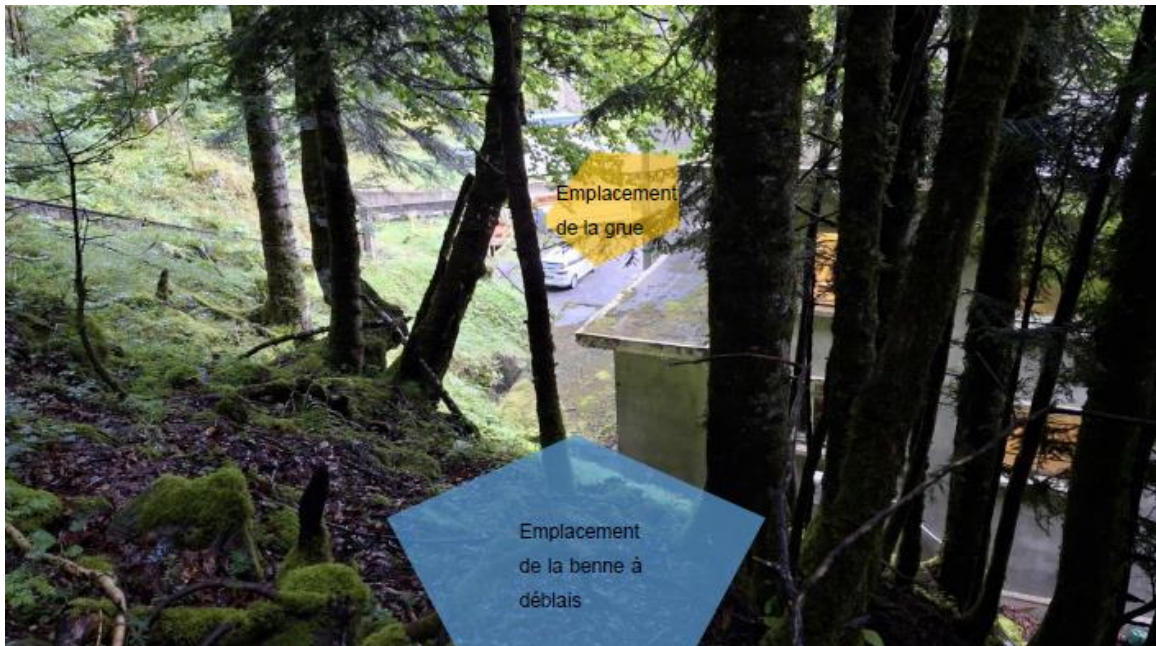
Figure 14 : Plan de principe pour l'évacuation des déblais
