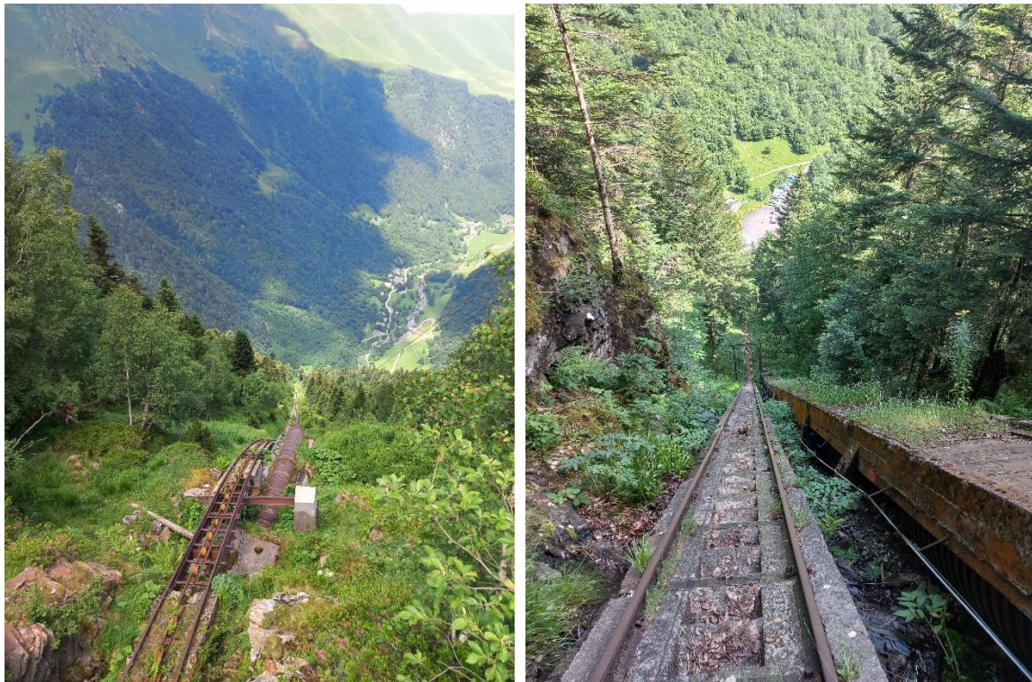
Figure 33 : Illustrations des milieux au droit de la conduite dans sa partie inférieure (zones de travaux N°1 et N°2) (Source : ING'EUROP juin 2025)
