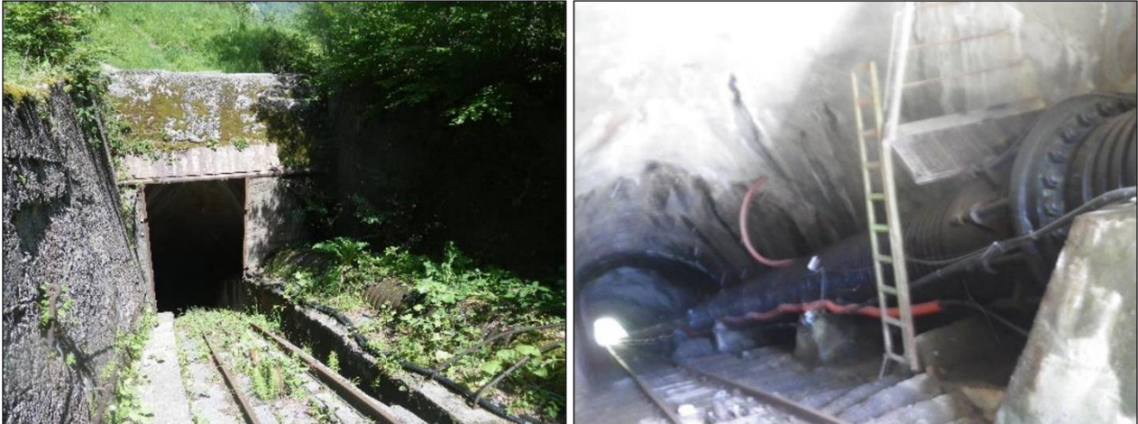
Figure 20 : Vue de l'entrée en galerie (à gauche) et du tronçon de CF en galerie ( à droite)
