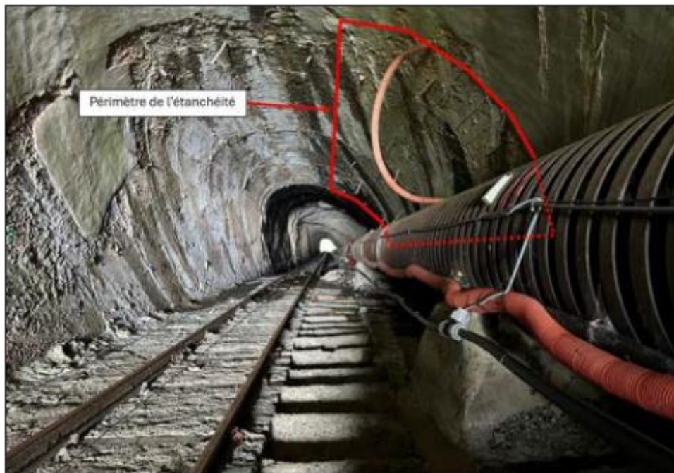
Figure 19 : Représentation schématique du périmètre de l'étanchéité (source GETEC)
