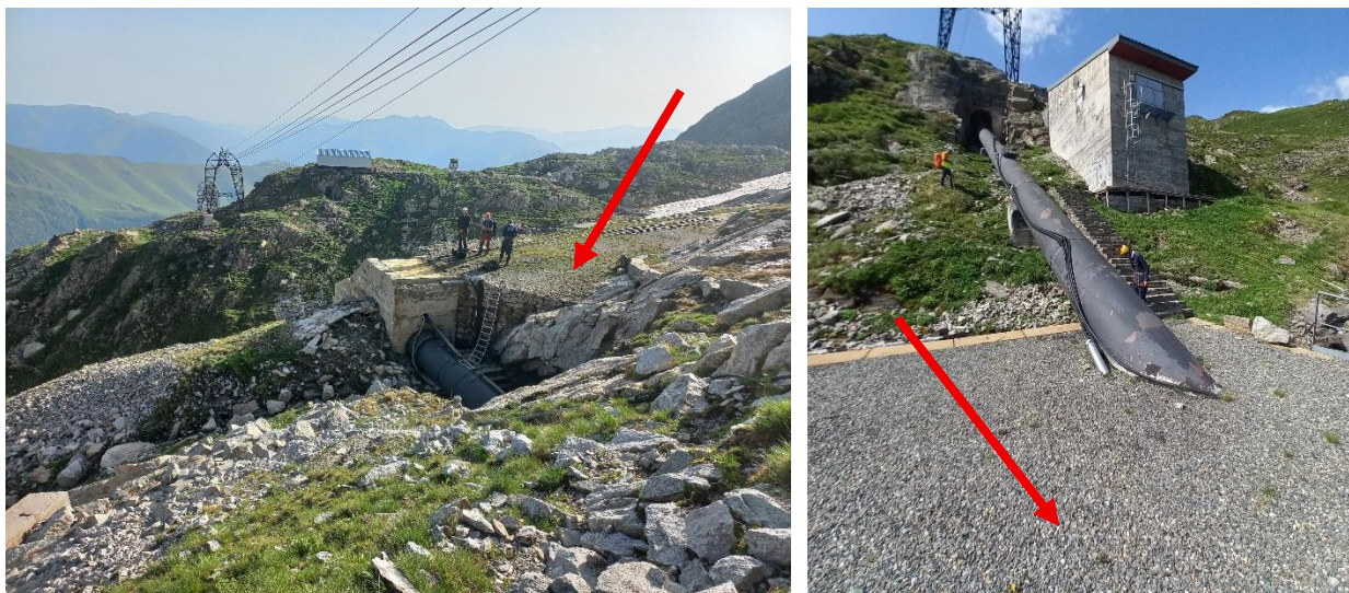
Figure 27 : Zone de replat à proximité de ST4 (à gauche) et à proximité de ST3 (à droite)
