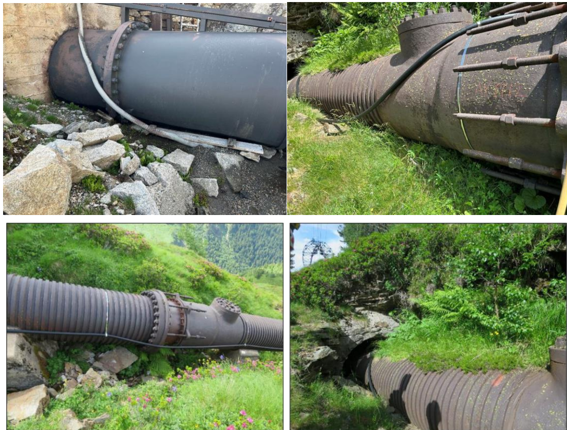
Figure 24 : Exemple de zones devant faire l'objet du rétablissement du tirant d'air sous la conduite
