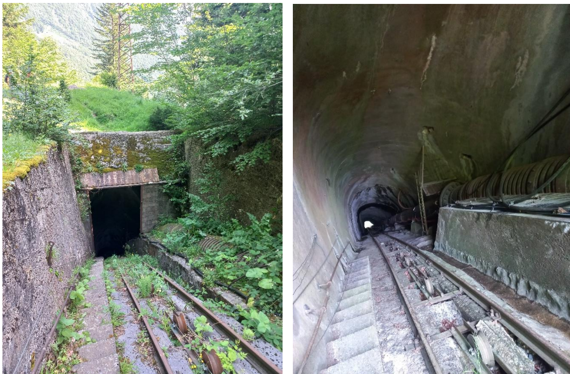
Figure 7 : passage de la CF en galerie
