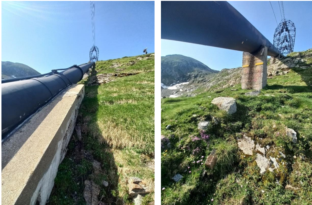
Figure 3 : Massif semi-englobant (à gauche) et sellettes de soutien (à droite) (Source : ING'EUROP juin 2025)
