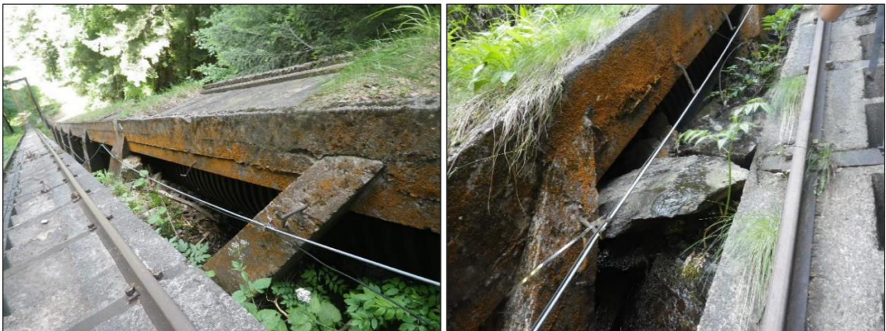
Figure 21 : Vue du platelage en bois surplombant la CF en sortie de galerie
