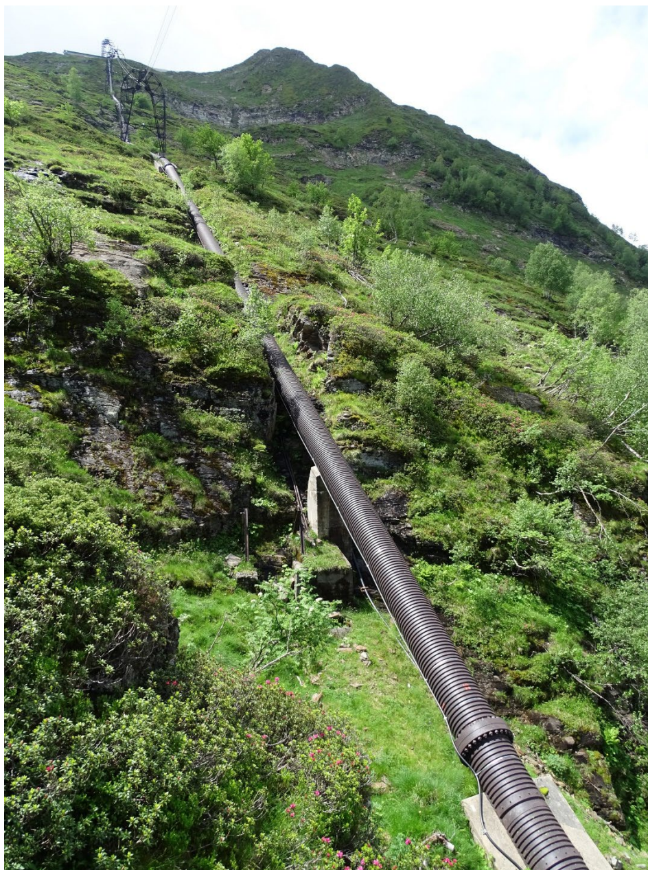
Illustration 1 : la conduite au-dessus de Prat-long
