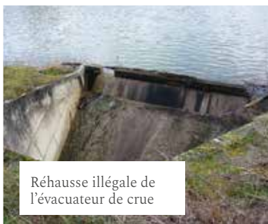
Évacuateur de crue très dégradé, mur béton fracturé, végétation
