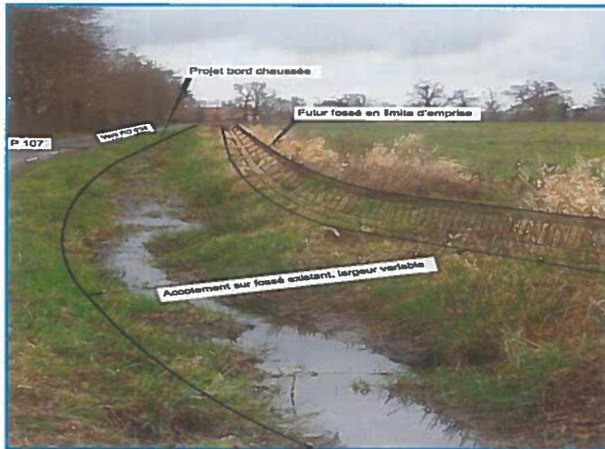
2. de la limite communale jusqu'à l'entreprise CASAUS (PR 42+160 au PR 41+295) sur une longueur de 860 mètres, l'élargissement et la mise en place des accotements porteront sur les côtés EST et OUEST. Le fossé en eau sera partiellement maintenu mais décalé.
