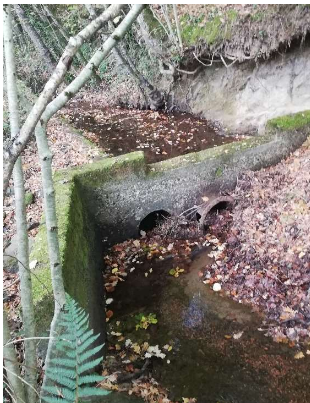
Figure 3 : Seuil en amont du canal bétonné
