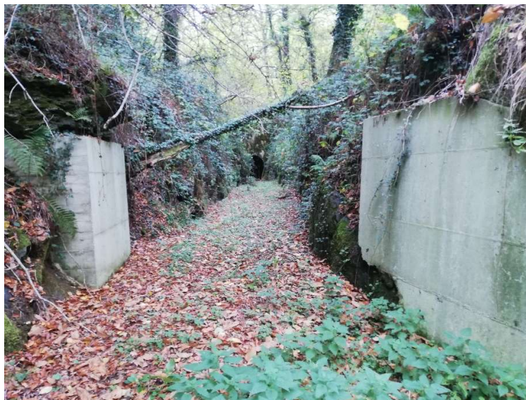
Figure 25 : Accès à la fenêtre de la Saignerie
