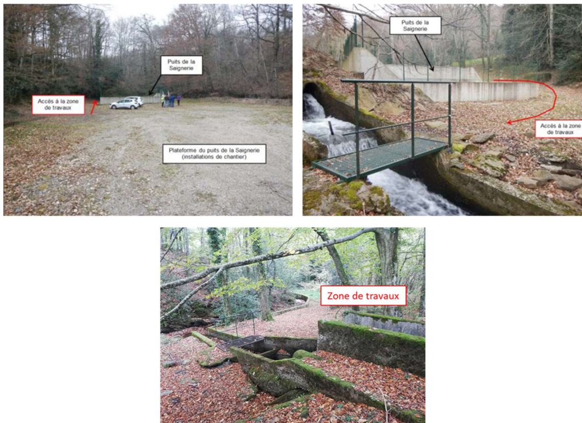
Figure 9 : Accès à la zone de travaux
