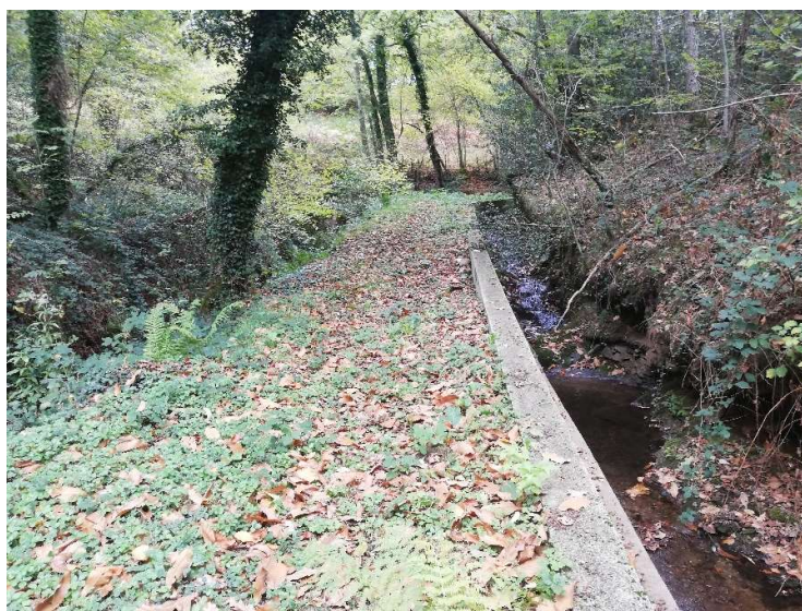
Figure 5 : Partie aval du ruisseau
