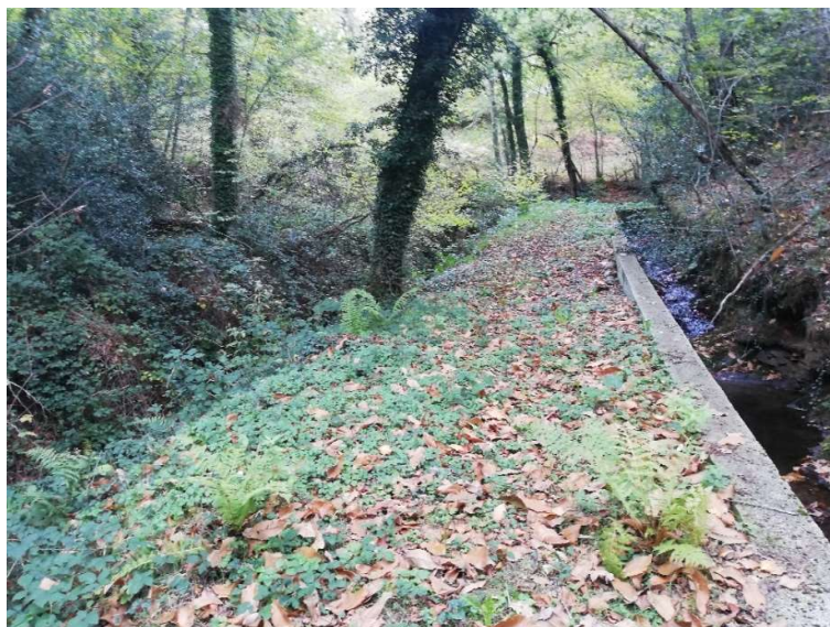
Figure 24 : Ruisseau de la Saignerie traversant une zone forestière
