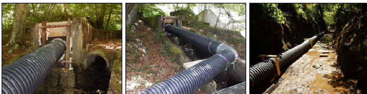
Figure 19 : dérivation provisoire installée lors des travaux de 2017
