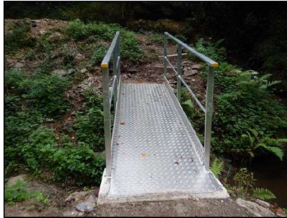
Figure 6 : Passerelle piétonne en aval du ruisseau
