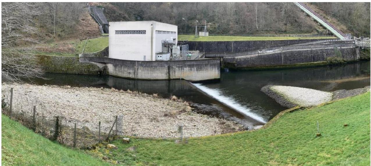
Figure 5 : Prise de vue depuis la RD – atterrissement créé et seuil du barrage garde gravier (photo EPIDOR)
