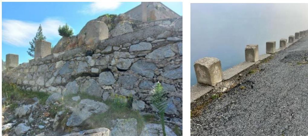
Figure 21. Route d'accès au couronnement – Dégradation et déformation de la route et du mur de soutènement (EDF, 2025)
