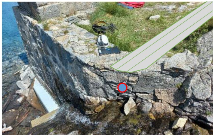
Figure 15. Mur de soutènement rive droite – Evacuation du drain et de la cunette (EDF, 2025)
