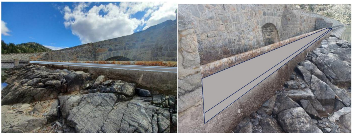
Figure 13. Déversoir – Confortement et étanchéité de la crête (EDF, 2025)
