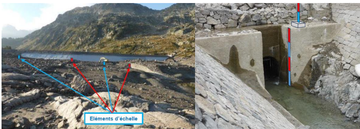
Figure 17. A gauche, mis en place d'éléments d'échelle sur des supports autostables (retenue). A droite, mise en place d'éléments d'échelle sur le GC et sur des supports autostables (EDF, 2025)
