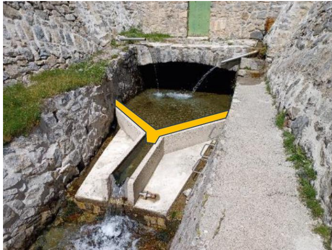
Figure 19. Pied aval du barrage – Système de filtration (EDF, 2025)
