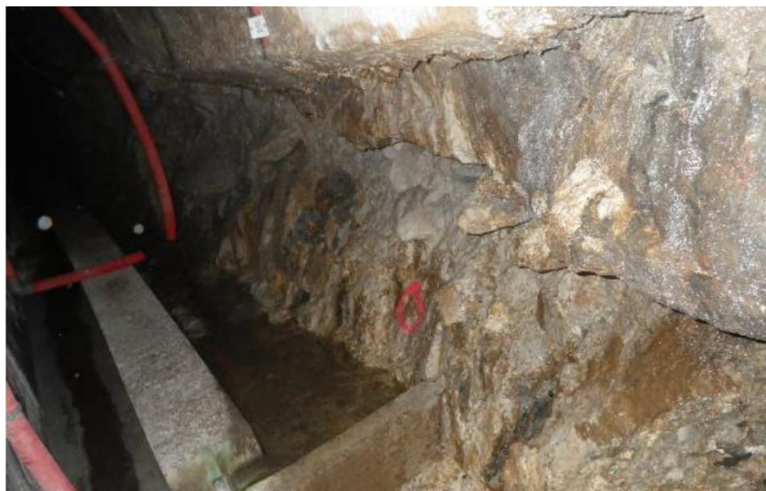
Figure 16. Galerie de drainage – Exemple de bac de mesure à réparer (EDF, 2025)
