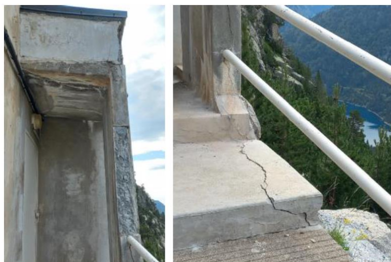
Figure 20. Local Vigie – Dégradation importante de l'auvent (EDF, 2025)
