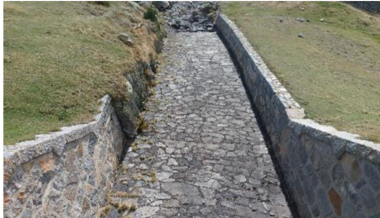
Figure 14. Radier du chenal maçonné – Dégradations des joints de maçonnerie (EDF, 2025)
