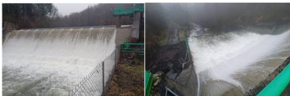
Figure 4 : Déversement sur l'ouvrage
