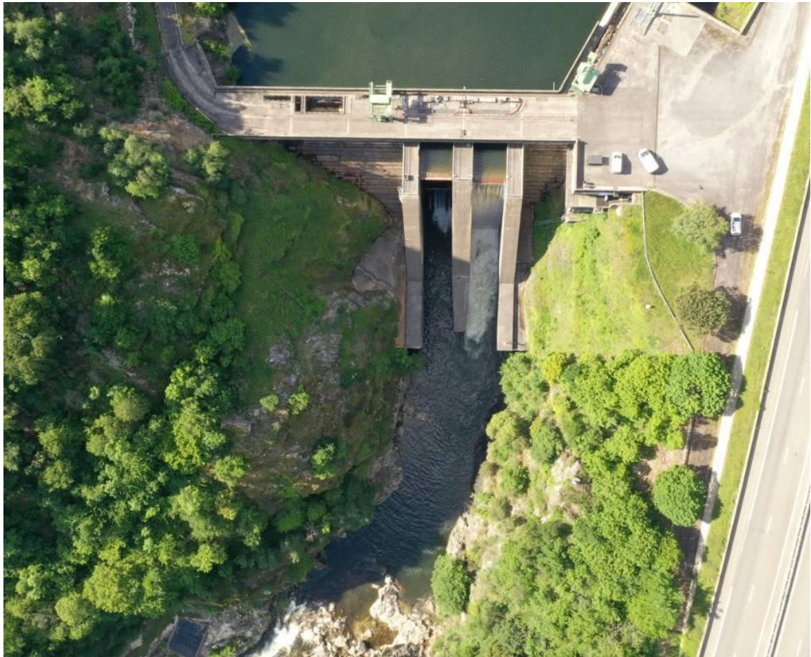
Figure 4 : Vue de dessus du barrage de Garrabet (source : EDF, mai 2020)
