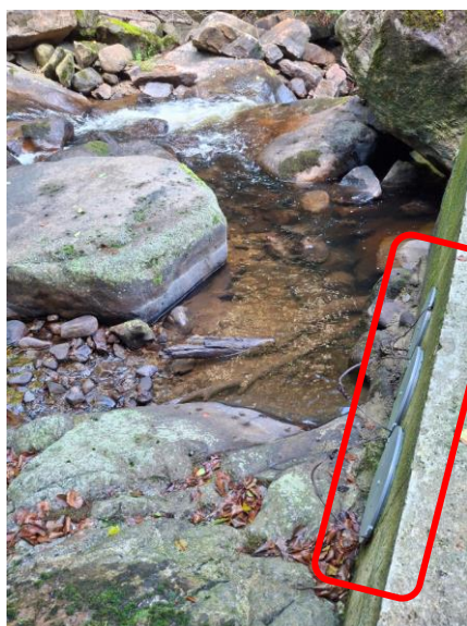
Figure 3: Vue amont piège à sédiments. Entrée des tuyaux de dérivation du débit entrant
