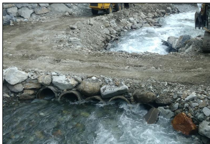
Figure 7 : Exemple de passage busé
