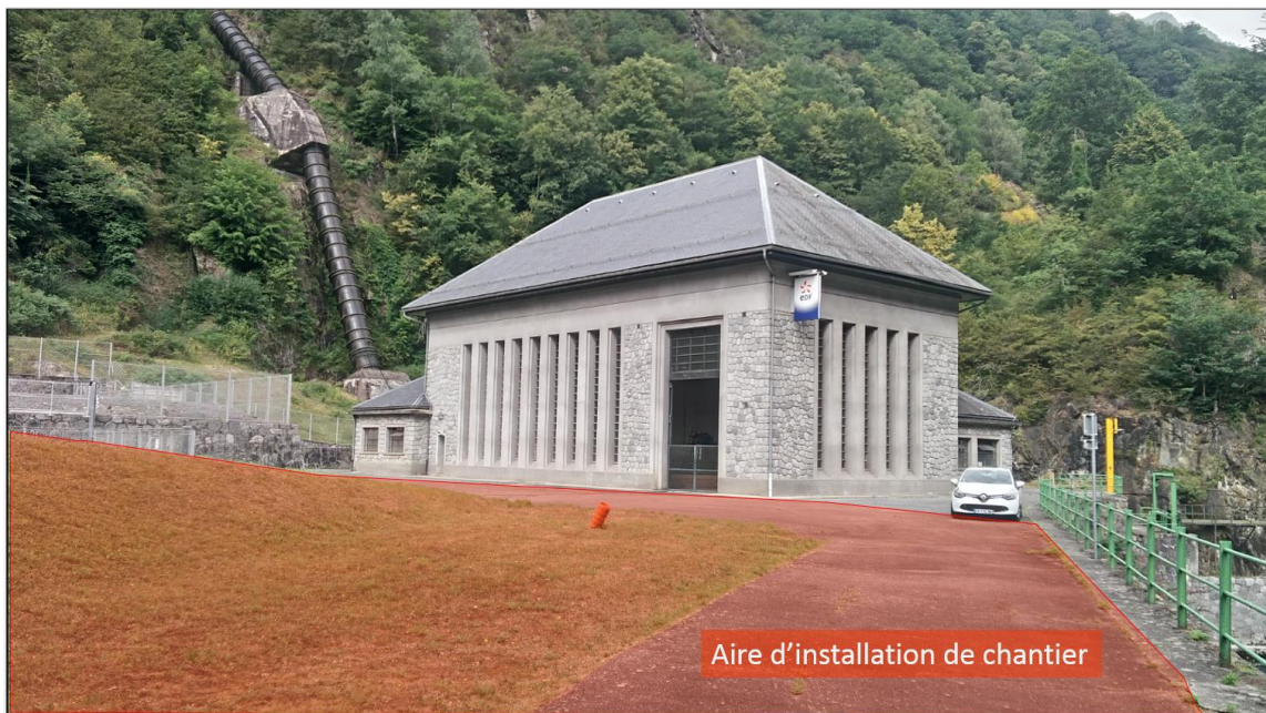
Figure 13 : Zone d'installations de chantier au Pont de la Reine
