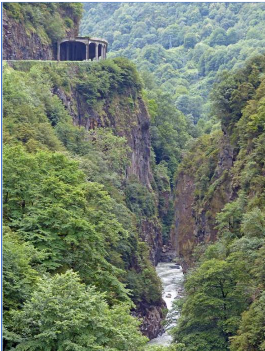
Figure 9 : Gave de Gavarnie dans les gorges entre le pont de la reine et Soulom
