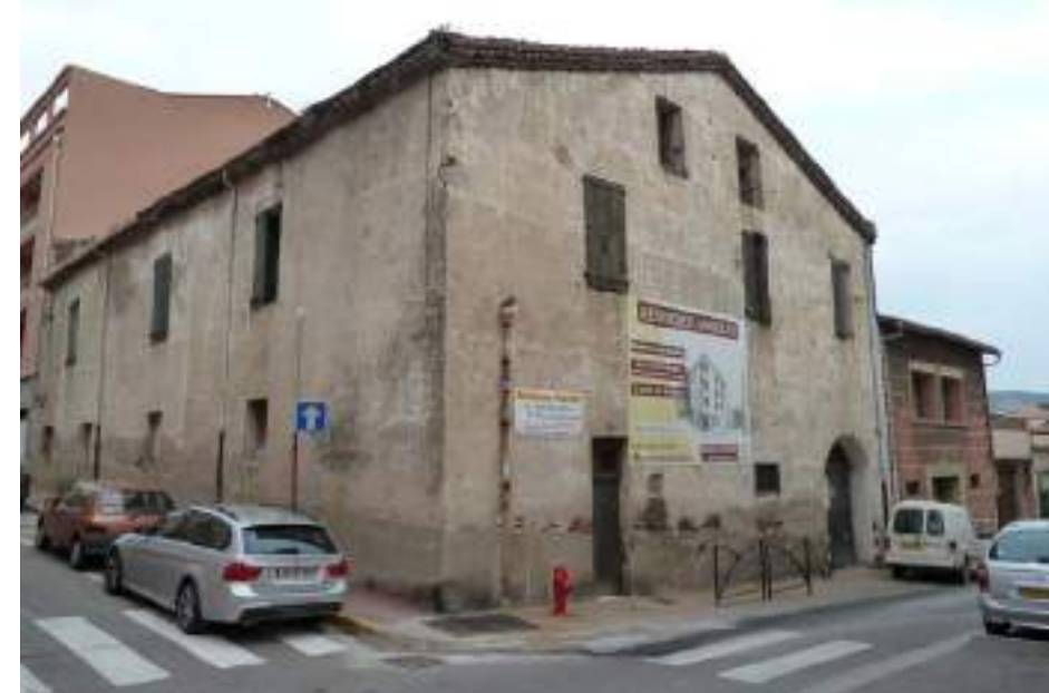
Projet de réhabilitation, Port-Vendres
