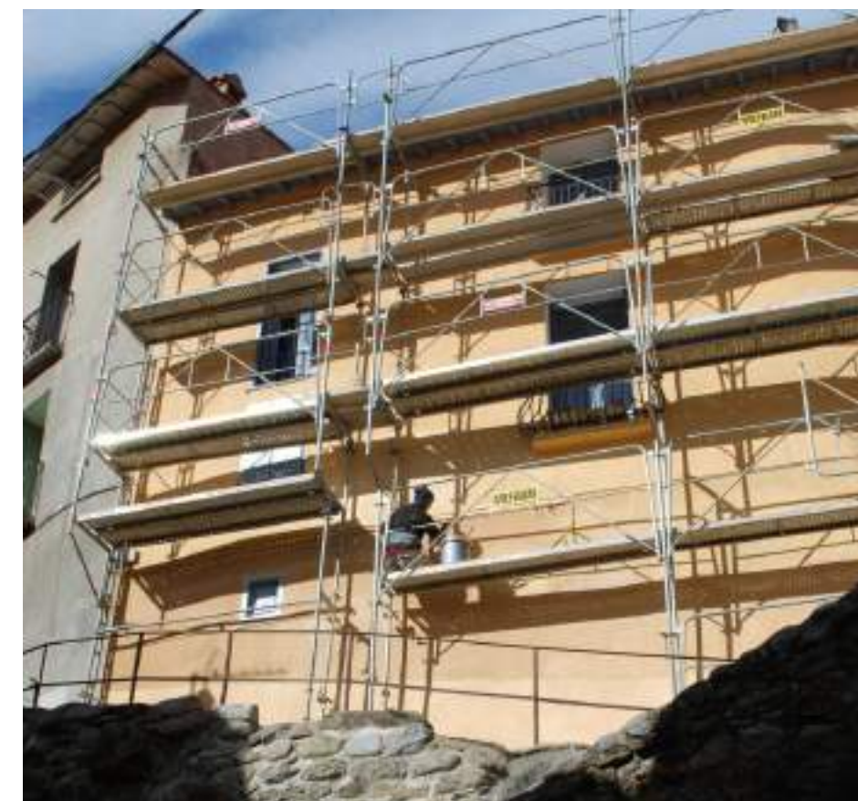
Façade en rénovation, Prats-de-Mollo
