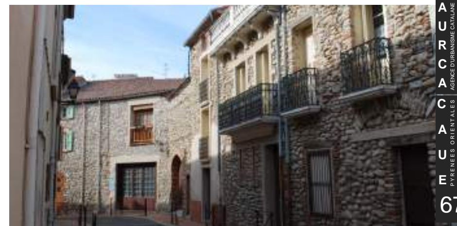
Façades rénovées, le Boulou
