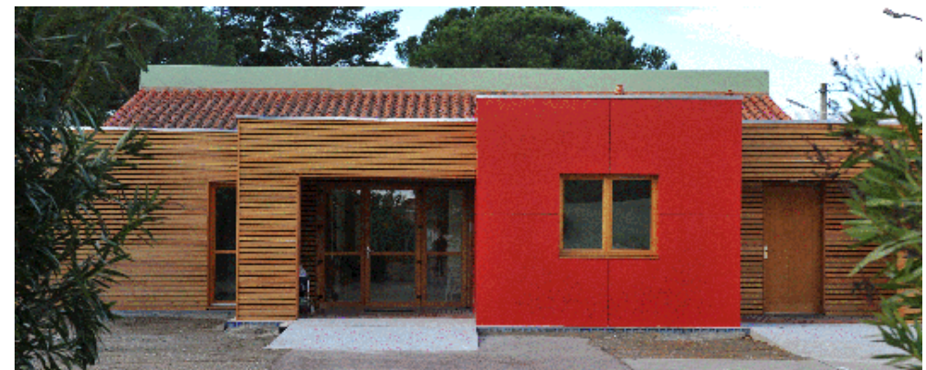
Crèche la Pinède au Boulou : un exemple de réalisation en ossature bois (Source : http://www.mairie-leboulou.fr )
