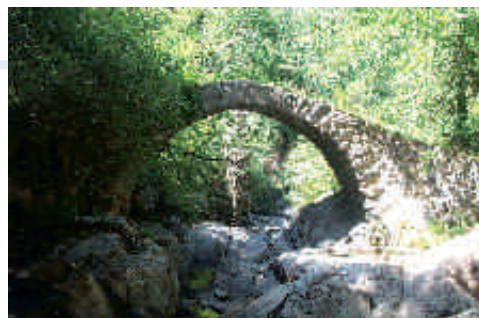
Peyrusse-le-Roc - Pont sur le torrent
