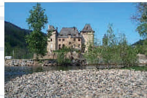
Entraygues, tenue des berges en traversée urbaine
