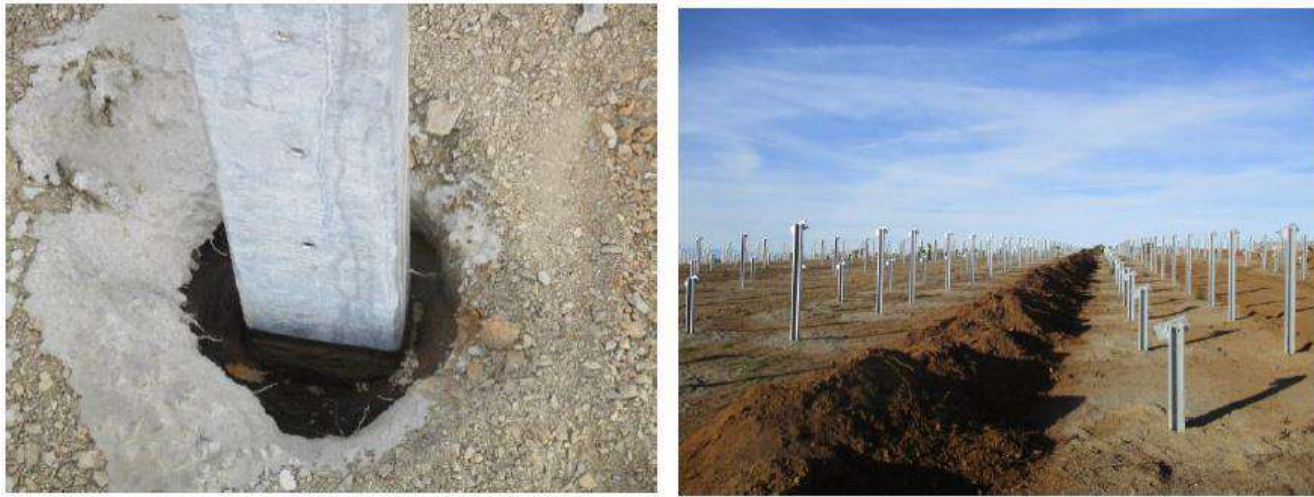
Figure 6 : Exemple de fondation type pieux – RES
