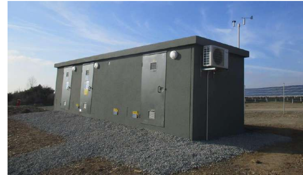
Figure 12 : Exemple de structure de livraison – RES
