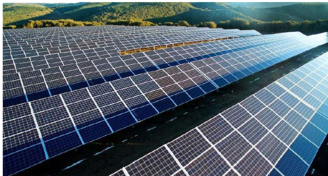
Figure 4 : Exemple de structure fixe – RES
