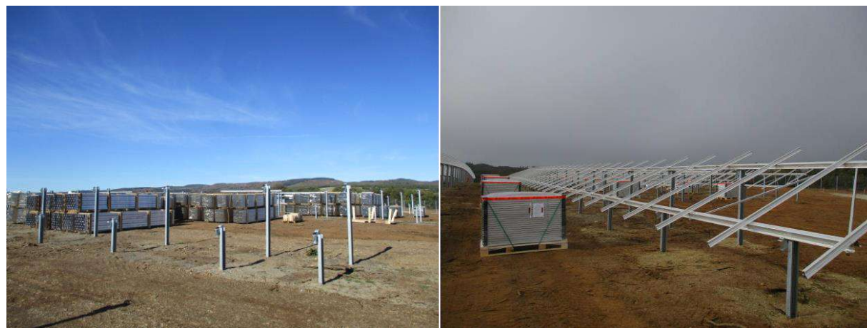
Figure 18 : Assemblage des structures sur site – RES
