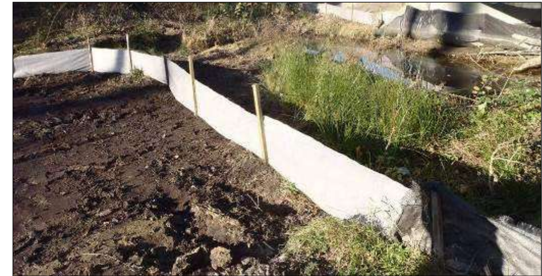
Figure 63 : Implantation de barrières amphibies en géotextile permettant d'éviter les déplacements des individus du cours d'eau vers le chantier © ETEN Environnement
