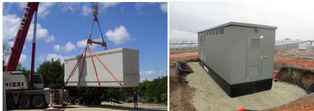
Figure 21 : Installation d'un poste électrique - RES
