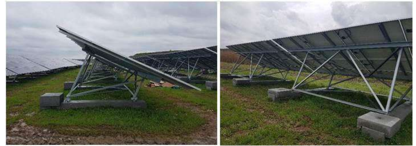
Figure 8 : Exemple de fondations béton - RES
