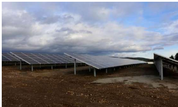
Figure 15 : Exemple d'espace non empierré entre tables – RES
