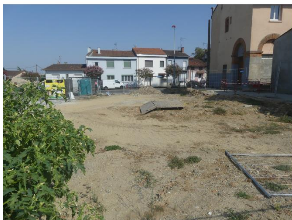
Après démolition, vers le cours des Ravelins
