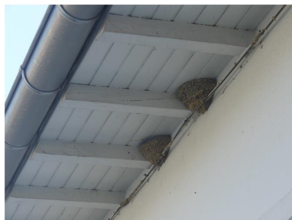
Installation de nid favorable : débord du toit suffisamment large
