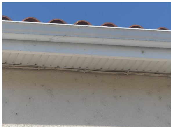
Installation de nid non favorable : débord de toit en PVC gênant l'accroche
