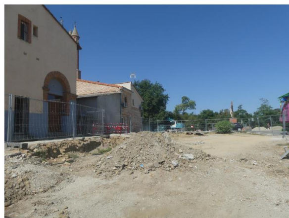
Après démolition, vers le parc du Vignaou
