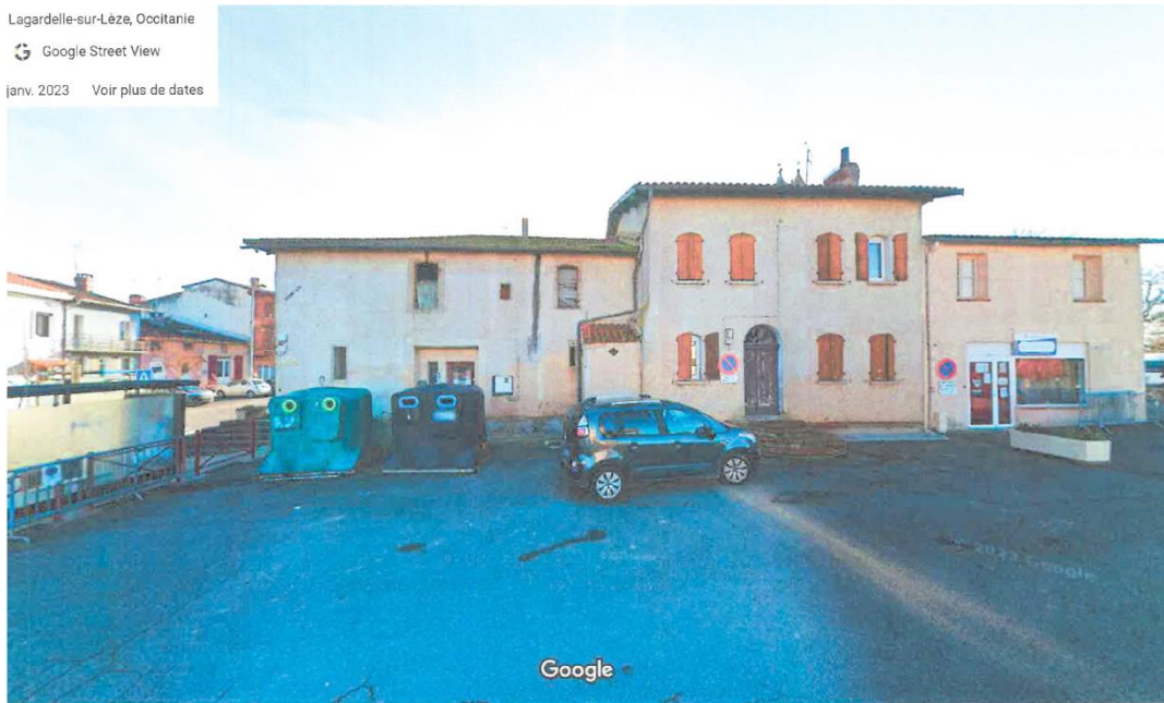
Maisons démolies en janvier 2025
