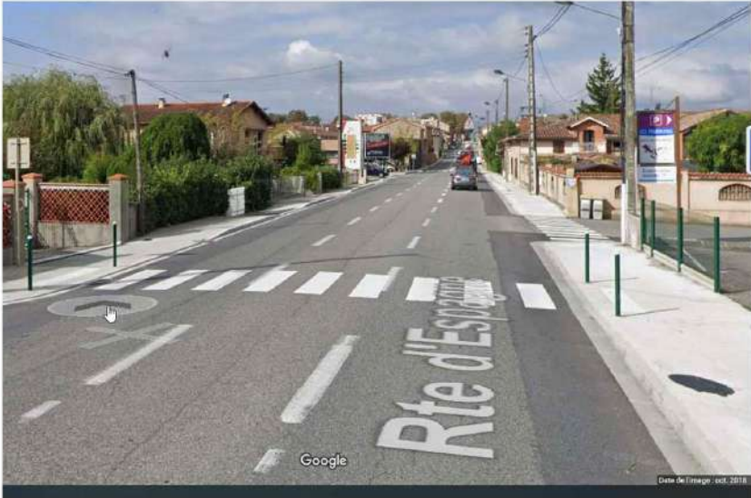
Photo Auterive RD820 de 2018 – passage piéton non sécurisé
