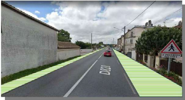
Bandes dérasées ou enherbées sans aménagement pour les piétons
