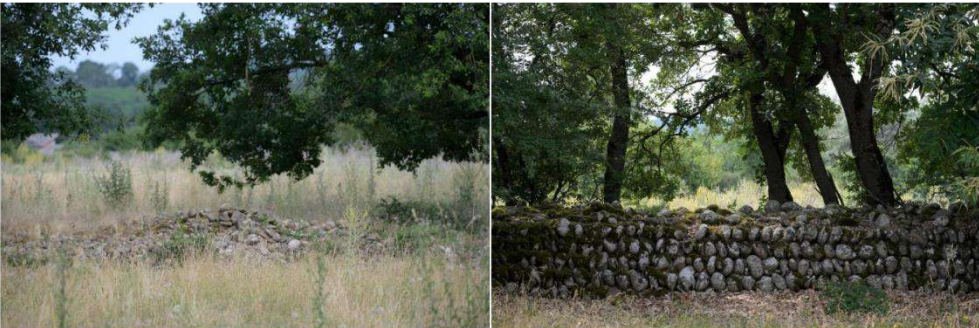
Vestige de muret à gauche et muret préservé en galets mais ombragé (ZI Delta SUD) à droite (G. Pottier, 2023)
