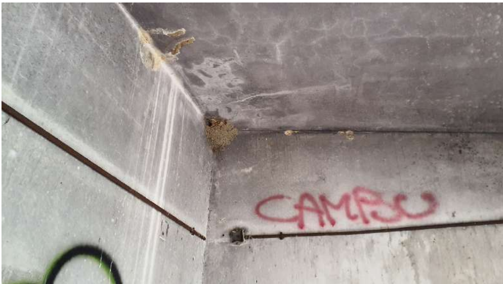
■ Photographie 12 : Deux anciens nids d'Hirondelle rousseline dont l'un occupé par le Moineau domestique dans un bâtiment de l'ancienne STEP concerné par la démolition
