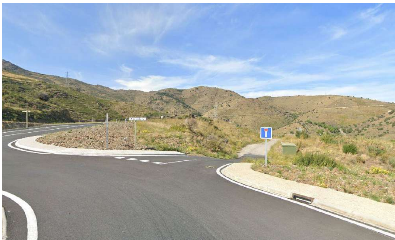
■ Photographie 6 : Vue 3 (vue du chemin d'accès à la STEP via la RD 914)
