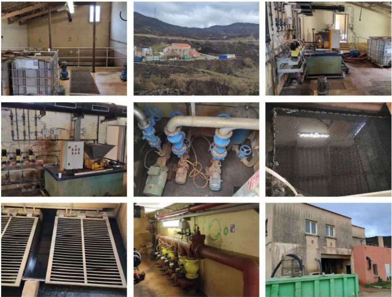
■ Photographie 3 : Relevés photographiques de la STEU existante
