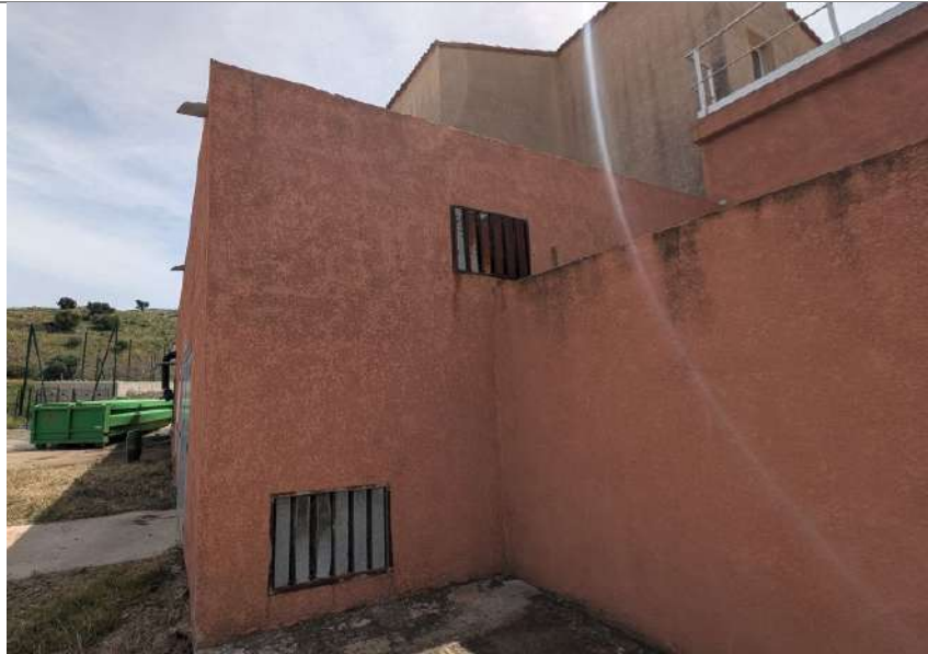
■ Photographie 18 : Extérieur du bâtiment de la STEP actuelle
