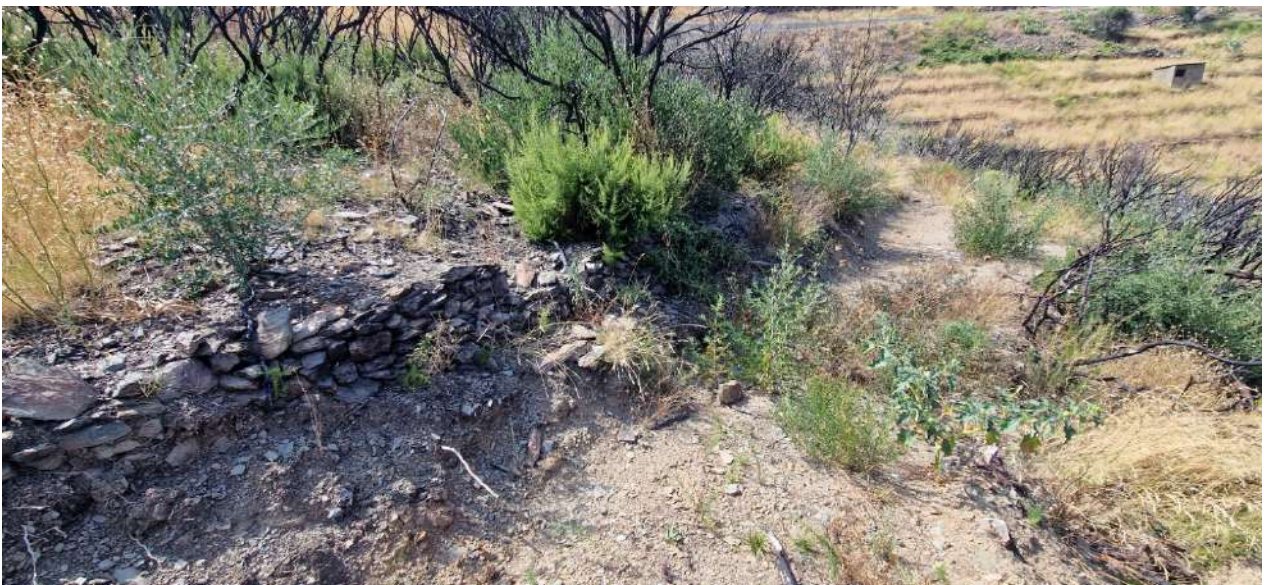
■ Photographies 15 : Muret au sein de l'emprise du projet d'extension - au Nord-Ouest de la STEP actuelle
