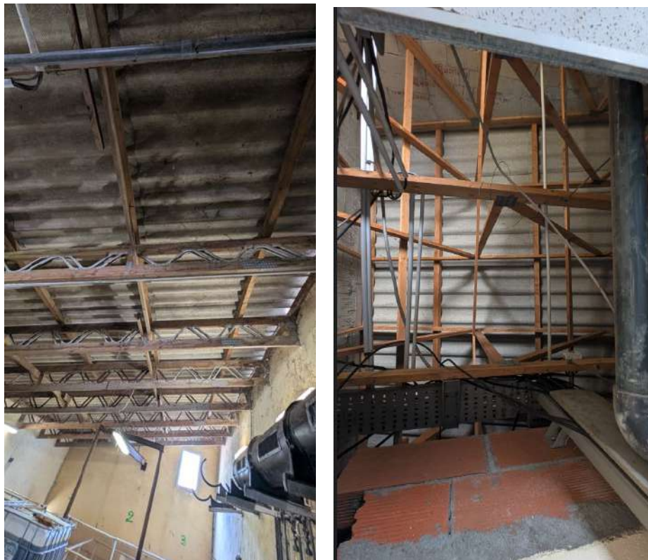
■ Photographie 19 : Sous toiture de la STEP actuelle
