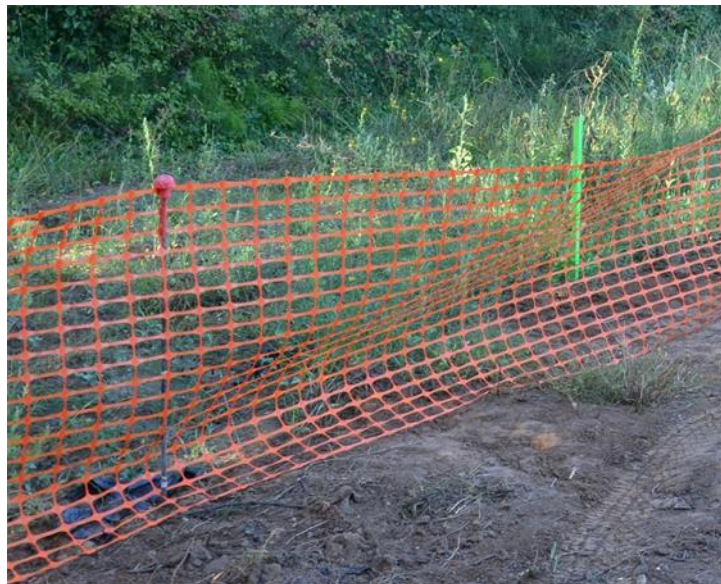
☞ Photographie 18 : Dispositif de limitation des emprises des travaux
