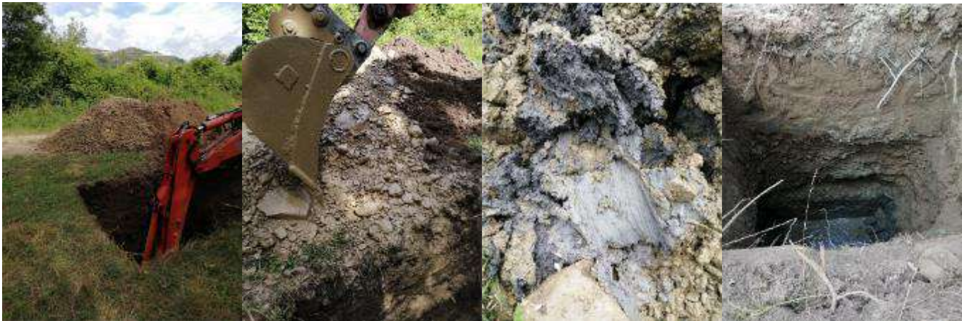
FIGURE 23 : PHOTOS DES SONDAGES S3 ET S4
