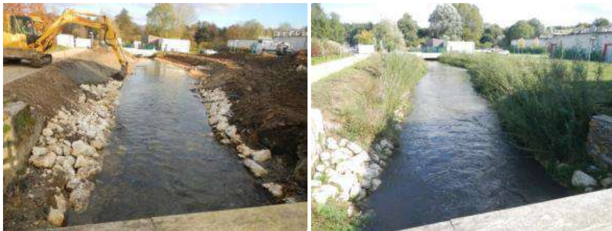
FIGURE 6 : EXEMPLES DE SEUILS DE FOND EN BLOCS MIS EN ŒUVRE DANS LE CADRE D'UNE OPERATION DE RESTAURATION DE TRONÇONS DE RIVIERE (SOURCE EGIS)
