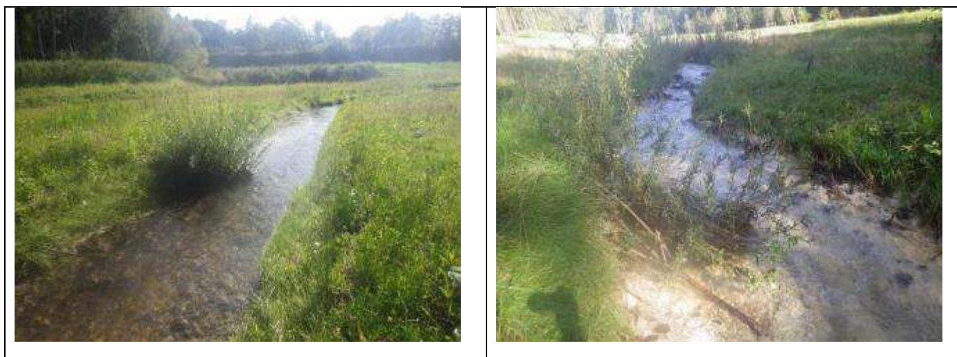
FIGURE 8 : VUES D'EPIS DEFLECTEUR VEGETAUX. SOURCE : EGIS
