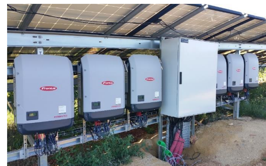
Onduleurs décentralisés et armoire électrique à l'arrière des panneaux (source : Luxel, 2017)
