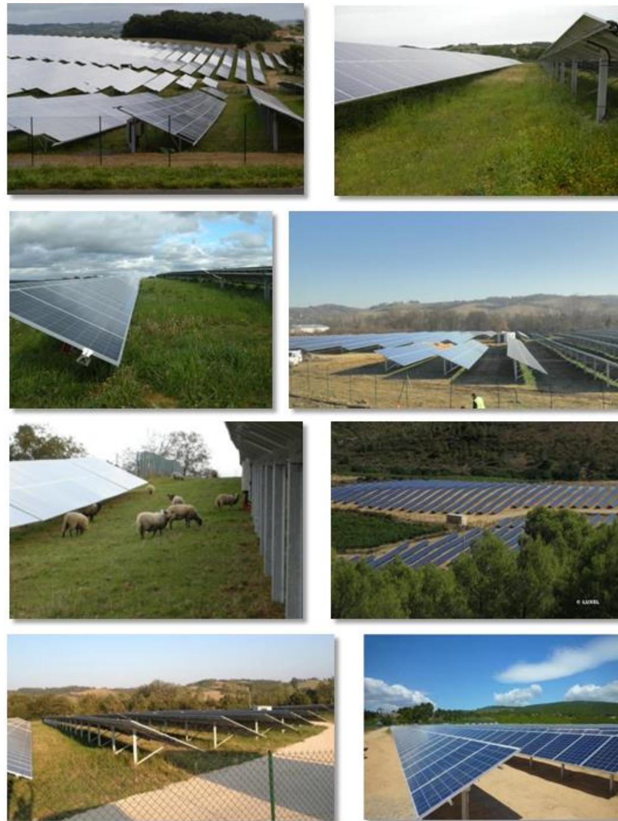
Exemple de centrales réalisées par LUXEL depuis 2008 (Source : LUXEL)
