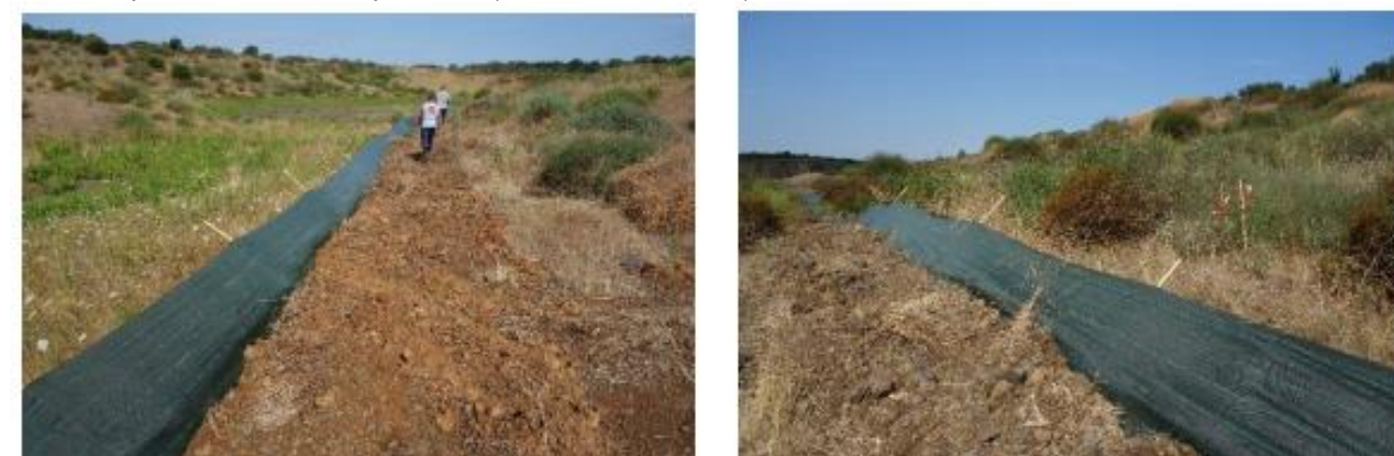
Photographie 3 : Exemple de barrière d'exclusion semi-perméable (source : MICA Environnement)
