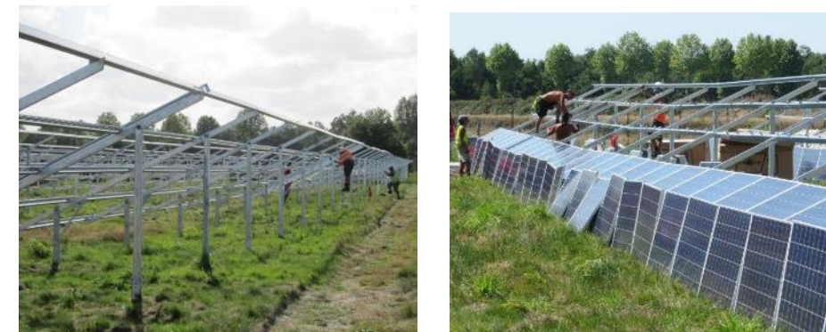
Pose des structures et des tables (Parc de Saint-Aubin de Blaye, Luxel 2013)
