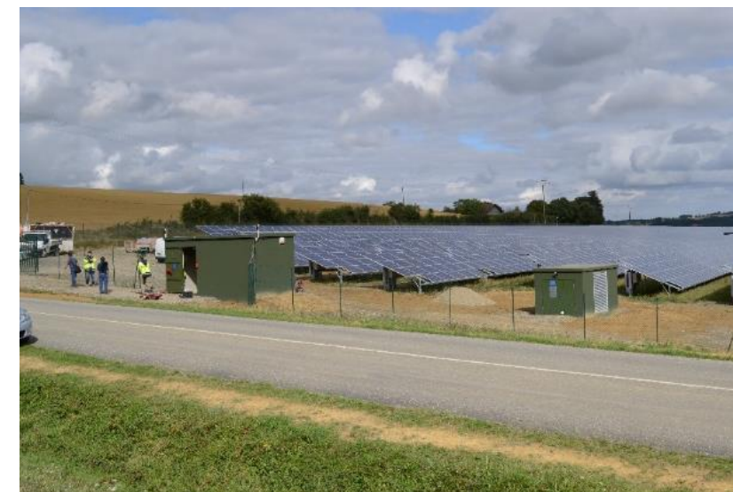
Exemple de poste de livraison et poste de transformation sur un parc solaire (source : Luxel, 2017)
