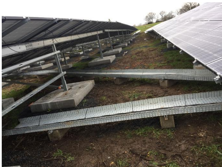
Figure 5 : exemple de cheminement de câbles hors sol
