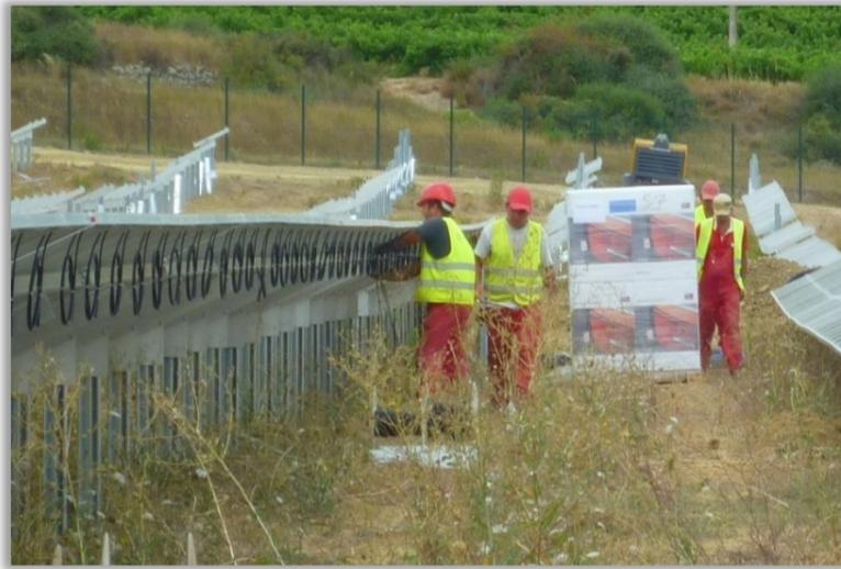
Câblage et interconnexion des modules photovoltaïques
