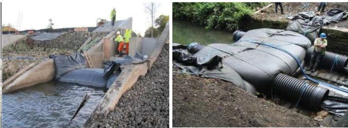
Figure 12 : Exemples de batardeaux envisagés pour l'assèchement du Canal (source : Arcadis)
