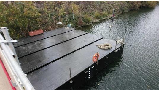
Figure 33 : Pontons modulaires – Source : Arcadis
