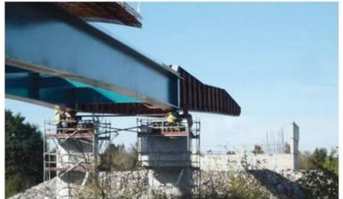
Figure 32 : Exemple de mise en place par lançage – Vue de la charpente et de son avant-bec – Source : Arcadis
