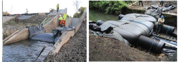
Figure 61 : Exemples de batardeaux envisagés pour l'assèchement du Canal (source : Arcadis)
