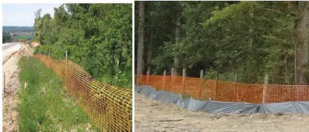
Exemple de barrière de chantier en limite d'emprise travaux
