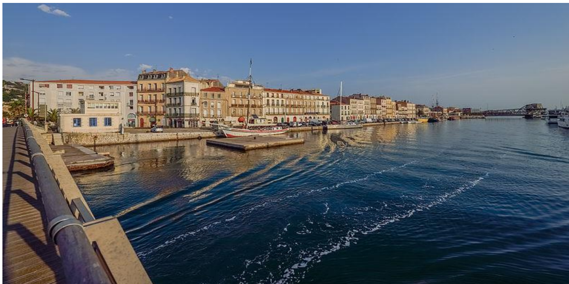
Figure 2 : Vue générale du quai de la République Nord
