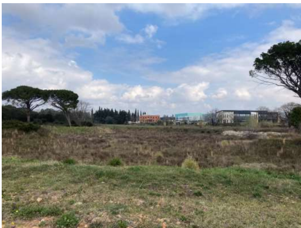
Exemple des 11 bassins de rétention aménagés dans la ZAC
