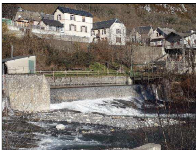
Figure 40 : Rive gauche du barrage
