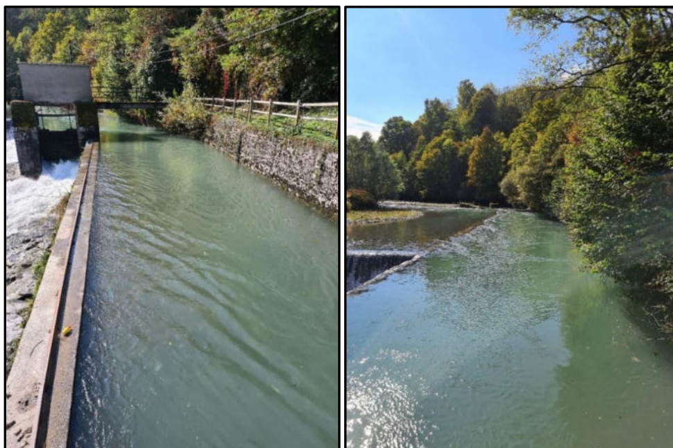
Figure 7 : Le barrage – vue depuis la prise d'eau (avant travaux 2023)
