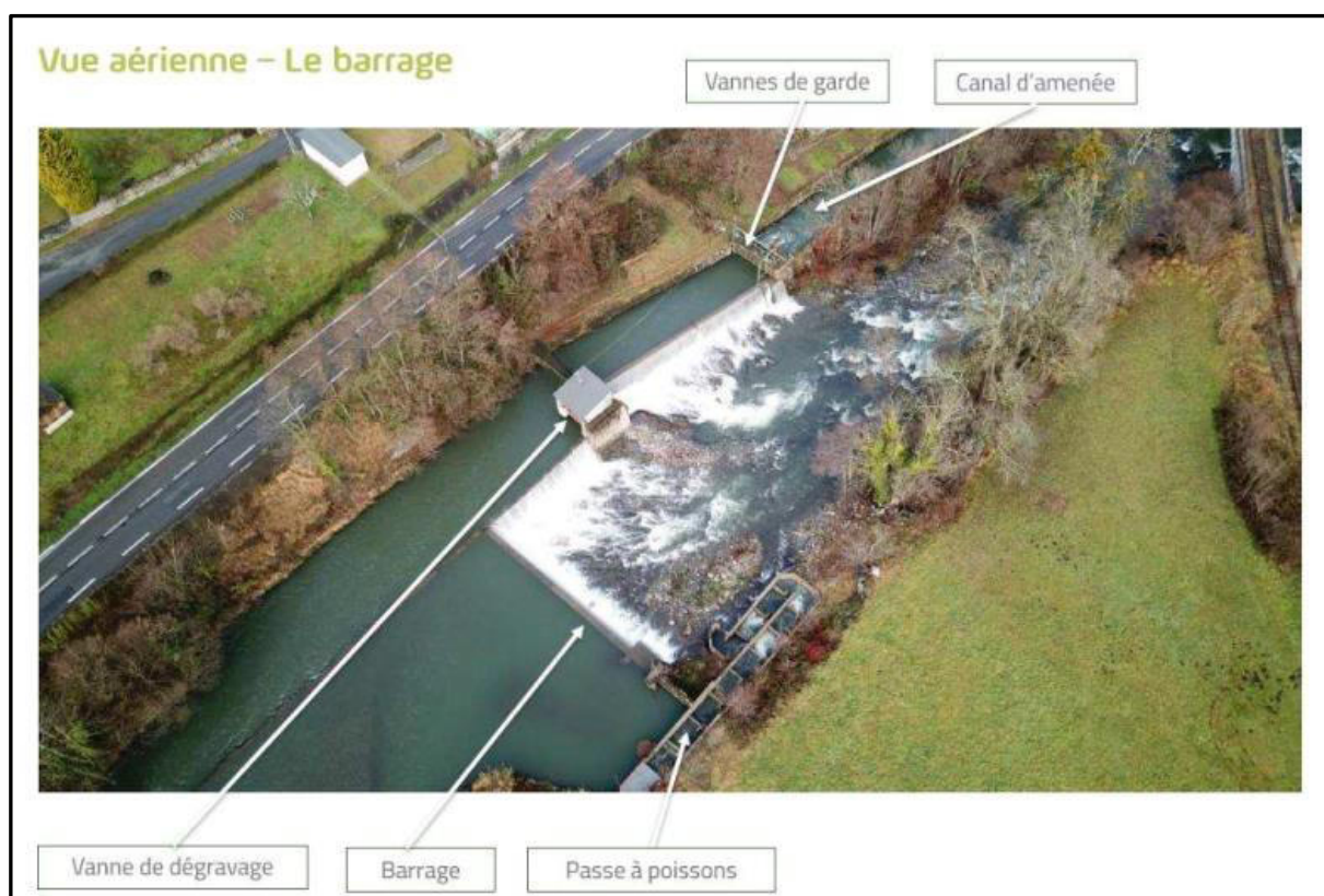
Figure 6 : Le barrage – vue aérienne avant les travaux de 2023 (source : Porter-à-connaissance de 2022)
