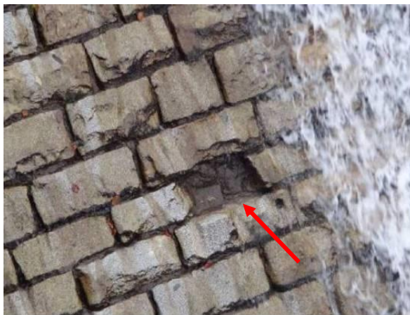
Figure 57 : Coursier aval vanne de chasse
