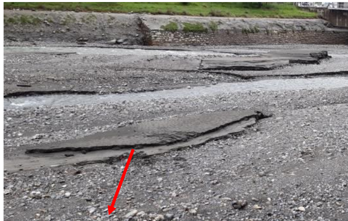
Figure 28 : Vue de la zone de prélèvement n°3
