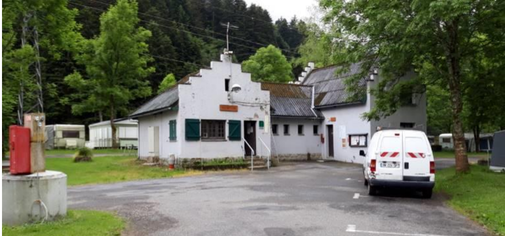
Figure 34 Vue de l'entrée du camping pour l'accès à la zone de travaux
