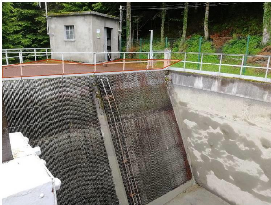
Figure 48 : Espace disponible au niveau du bassin de décantation de la prise d’eau
