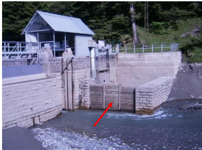
Figure 50 : Vue du batardeau amont du bassin de décantation
