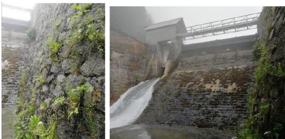
Figure 53 : Exemple de la végétation présente sur le bajoyer en RG aval (à gauche) et sur le coursier (à droite)
