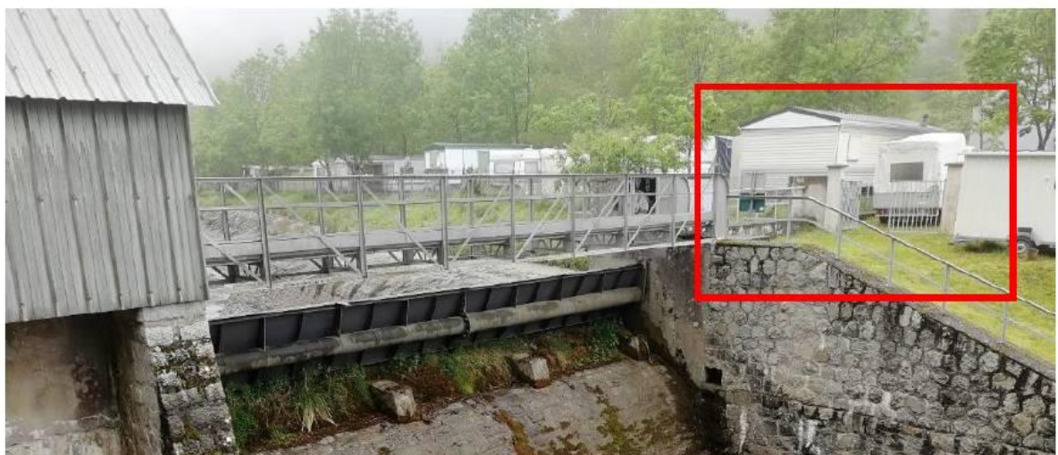
Figure 46 : Vue de l'accès au barrage en rive gauche
