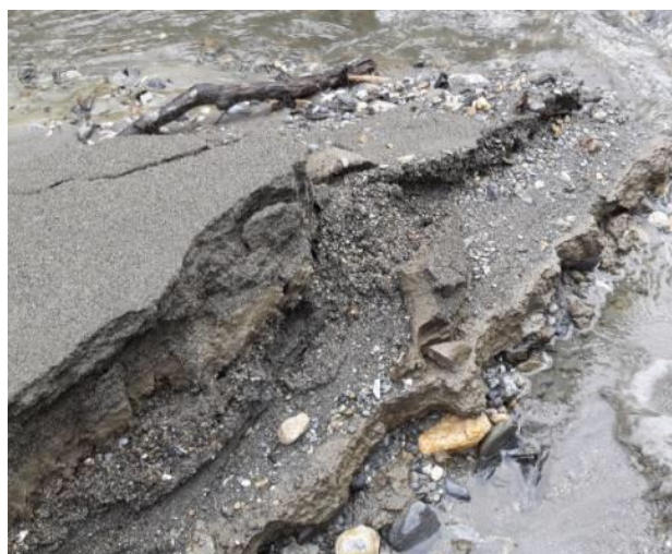
Figure 26 : Vue de la zone de prélèvement n°1
