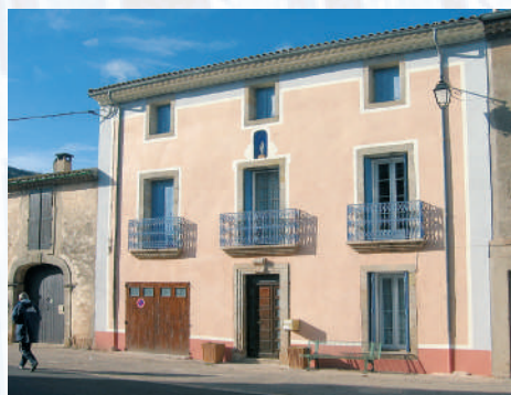
Réhabilitation à Salasc
