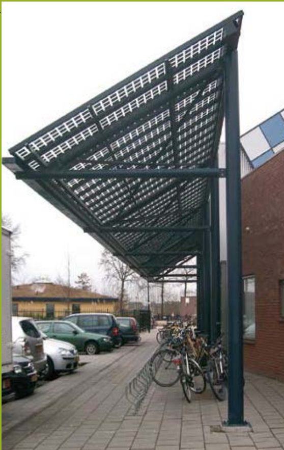
Panneaux photovoltaïques pour protéger un parking à vélo
