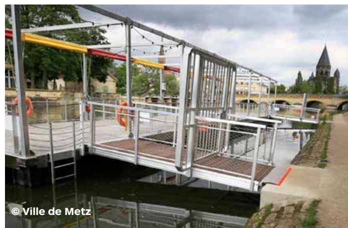
Passerelles faisant office de dracons avec la mise en place de deux massifs en béton permettant l'accroche des passerelles.
