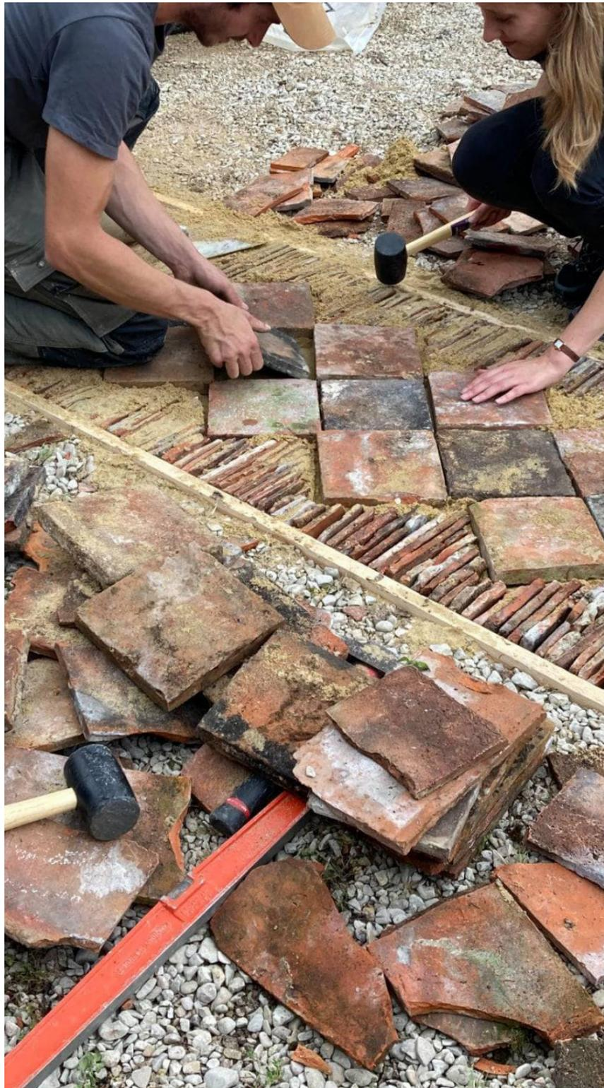
*Réemploi de tuile et de carreau de terre cuite. Chantier réhabilitation et construction d'une extension, Sap-en-Auge, Anatomie d'Architecture, photographie Ada*
