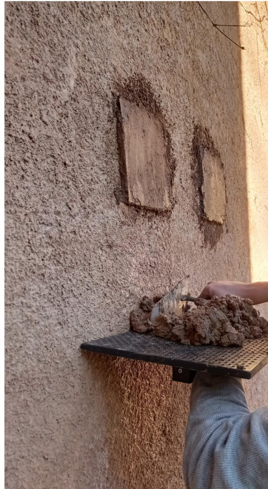
*Recherche et application d'enduit à la chaux. Chantier réhabilitation et construction d'une extension, Sap-en-Auge, Anatomie d'Architecture, photographie Ada*
