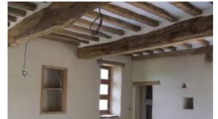
*Réhabilitation du bâti existant : purge des anciens enduits, dépose des coffrages ou parement. Nettoyage et application d'un enduit chaux chanvre, mise en valeur des poutres, pose de menuiserie bois*
