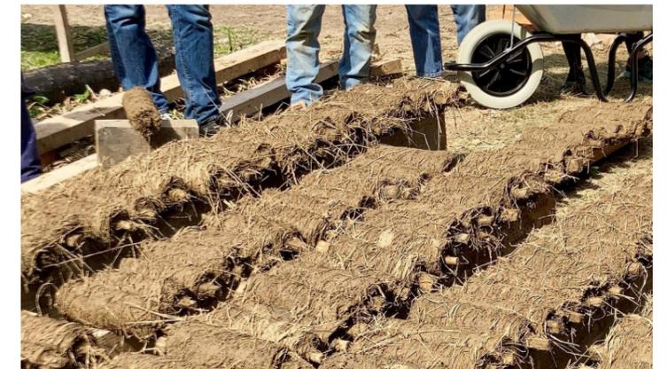
*Réintroduction d'une technique constructive : la quenouille. Chantier réhabilitation et construction d'une extension, Sap-en-Auge, Anatomie d'Architecture, photographie Ada*
