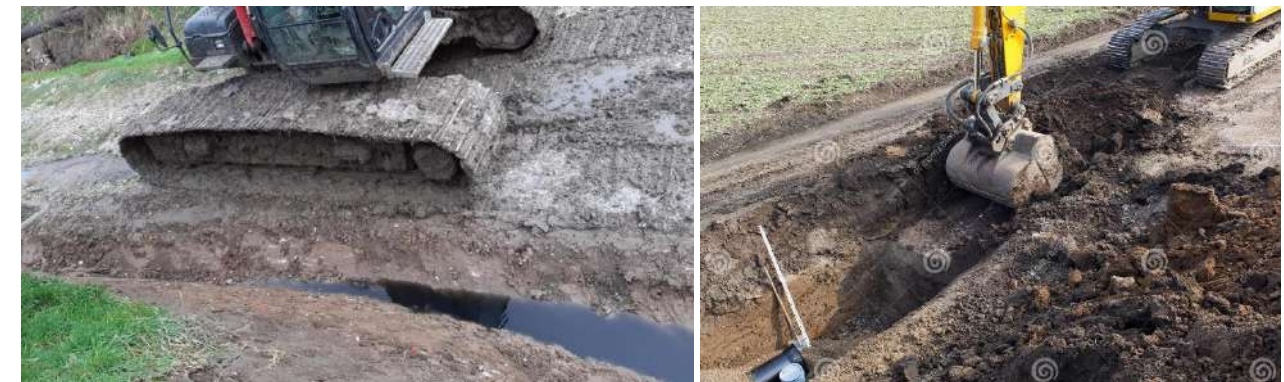
Figure 19 : Illustration d'un chantier de creusement d'un fossé
