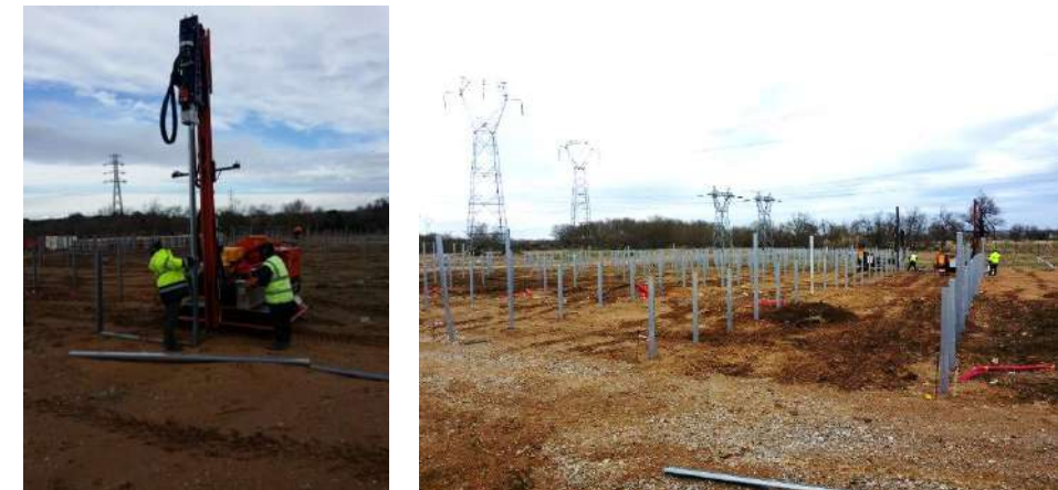
Mise en place des pieux battus
