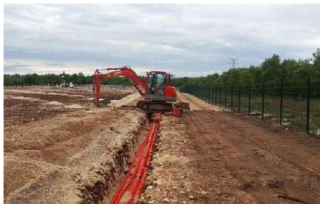
Enfouissement des réseaux
