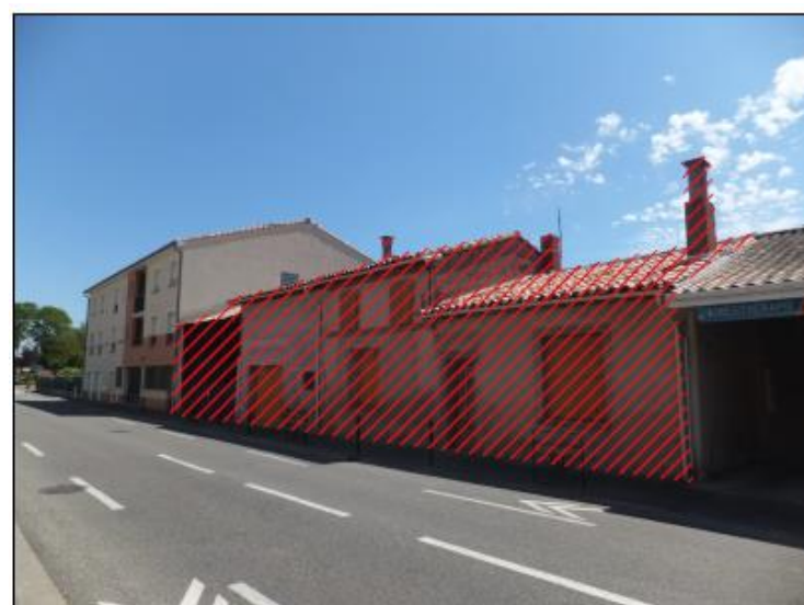
Maison à détruire rue Clément Ader
