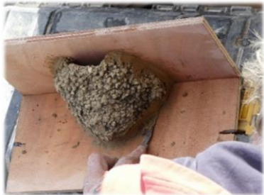
3/ Renforcement progressif de la barbotine au niveau sur les deux surfaces de contact
