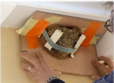
4 / Positionnement de l'ensemble sur les crochets après ajout d'une lanière de maintien temporaire
