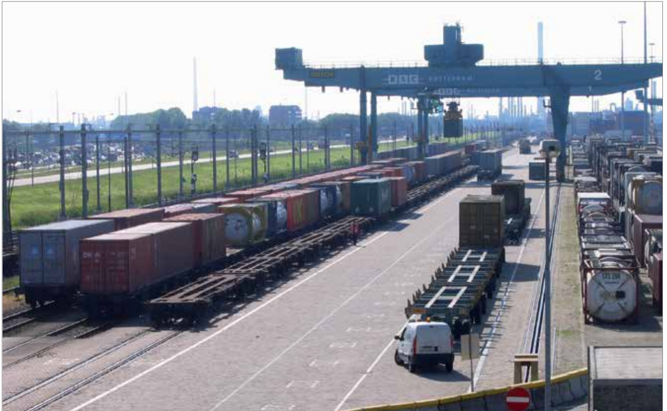
Portique de chargement sur un terminal de transport combiné maritime (port de Rotterdam aux Pays-Bas) / photo: SYSTRA
