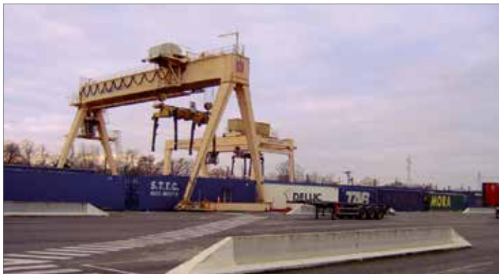
Portique de chargement d'un terminal de transport combiné terrestre / photo: SYSTRA
