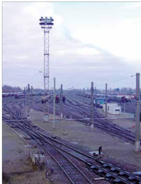
La plate-forme ferroviaire de Saint-Jory / photo: SYSTRA
