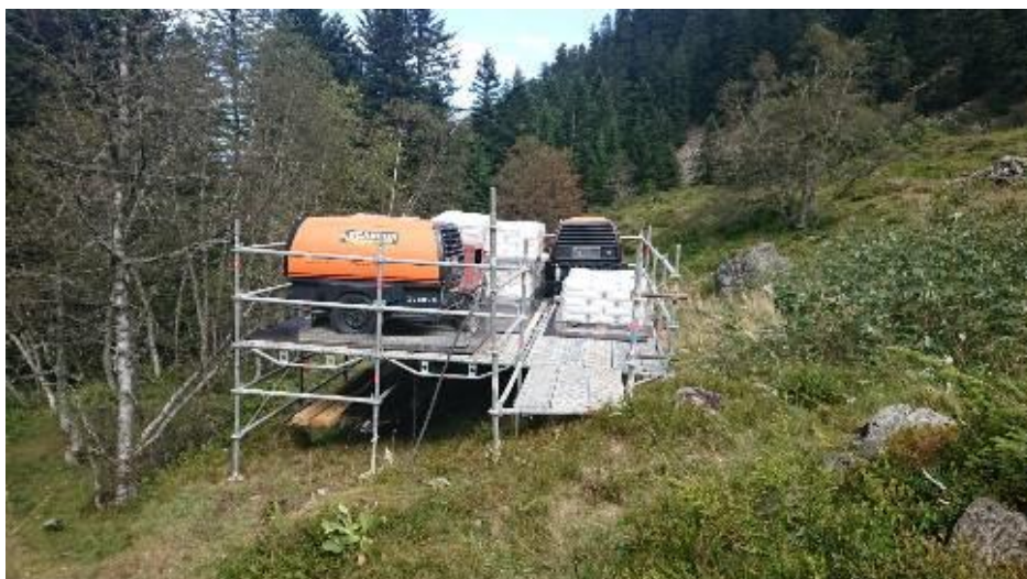
Figure 50 : Exemple d'installations de chantier sur une plateforme d'échafaudage
