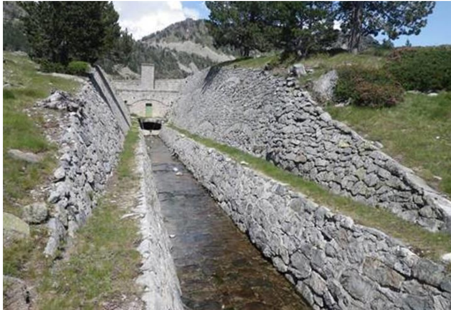
Figure 6 : Vue depuis l'aval du barrage, de la tranchée et du canal de fuite
