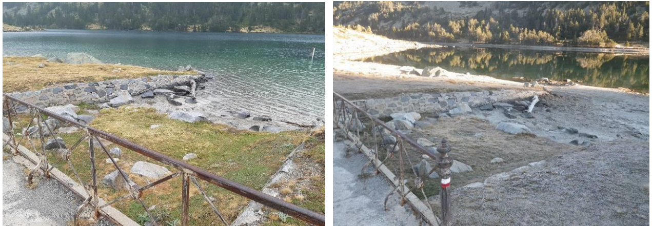
Figure 13 : Zone de travaux au niveau de la retenue le 2 septembre 2021 (cote haute) et le 28 octobre 2021 (cote basse)
