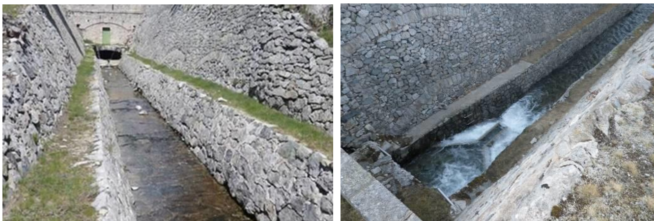
Figure 52 : A droite débit de fuite d'environ 6,6 l/s à l'étiage. A gauche photo du 28 octobre 2021 avec un débit d'environ 400 l/s lors du déstockage d'Aumar dans Aubert par les vidanges de demi-fond.
