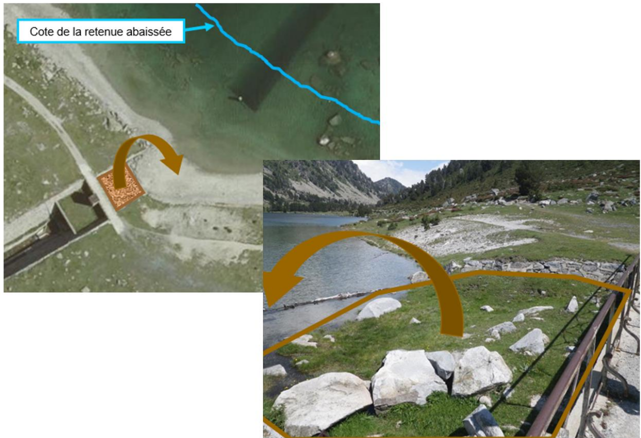
Figure 36 : Vue du déblai et de la mise en dépôt provisoire après abaissement de la retenue (-4 m)
