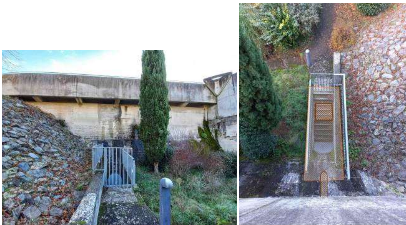
Figure 18 : Vues sur l'escalier et ses abords menant à l'accès RD depuis l'aval puis depuis le couronnement + principe d'obturation de l'accès
