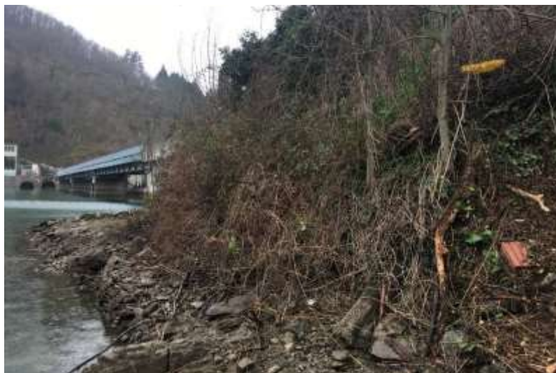
Figure 12 : Vue sur l'état existant du talus en berge amont rive droite (cote du plan d'eau = 318,35 m NGF)
